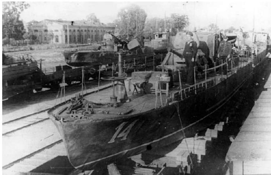
Рисунок 5 – Транспортировка катеров Днепровской флотилии по железной дороге
