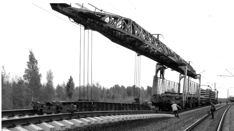
Рисунок 9 – Укладка звеньев путеукладочным краном УК-25/9-18
