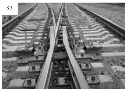
Рисунок 17 – Крестовина с подвижным сердечником с гибкими ветвями из рельсов острякового профиля с рельсовыми усовиками из спецпроката:
