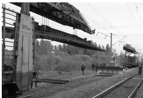
Рисунок 10 – Смена рельсошпальной решетки путеукладочными кранами УК-25/9-18
