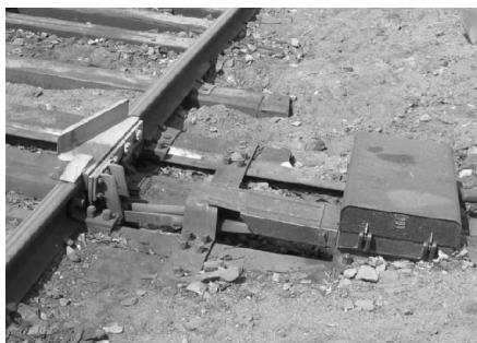
Рисунок 13 – Сбрасывающий башмак
