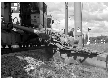
Рисунок 2 – Планировка откосов плугом
