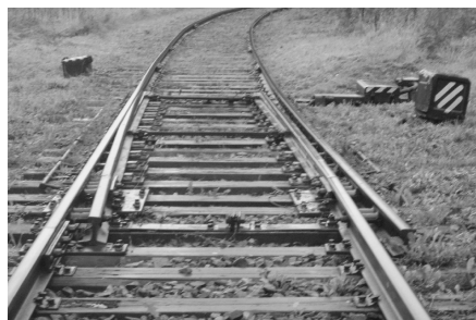
Рисунок 15 – Сбрасывающая стрелка
