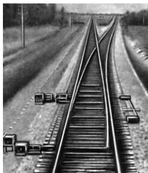
Рисунок 1 – Одиночный обыкновенный стрелочный перевод
