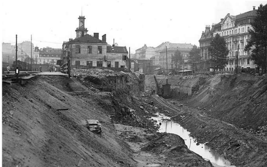
Рисунок 9 – Строительство туннеля диаметральной линии у Главного вокзала, 1931 г.
