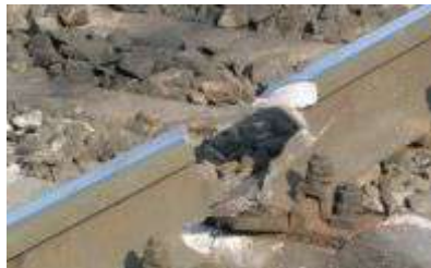
Рисунок 2 – Разрушение рельса под действием ударной нагрузки от колеса при низкой температуре
