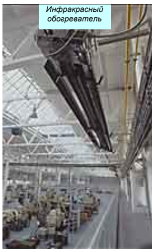
Рисунок 45 – Система газового лучистого отопления с инфракрасным обогревателем
