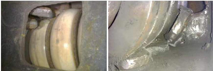
Рисунок 4 – Последствия разрушения пластин неподвижных
