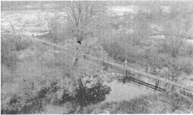
Рисунок 2 – Пример реализации пешеходного моста с использованием сборно-разборного металлического мостового пролета (СРММП-1) на болотистой местности
