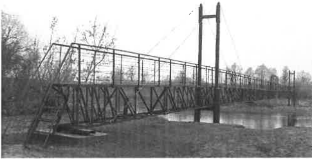
Рисунок 5 – Пример реализации вантового пешеходного моста с использованием блоков ригелей проекта 5254
