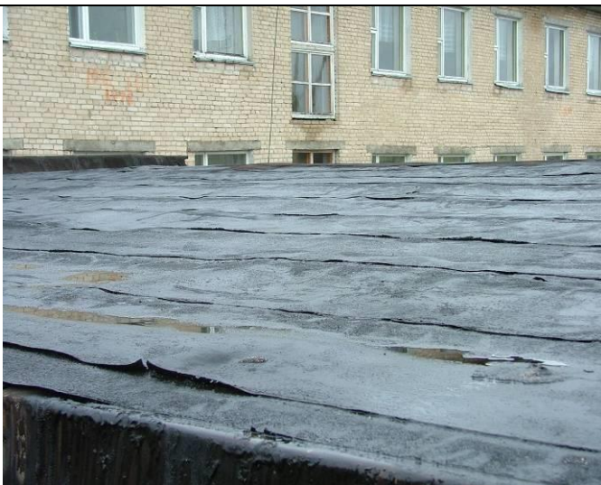
Рисунок 6.25 – Фрагмент рулонной кровли
