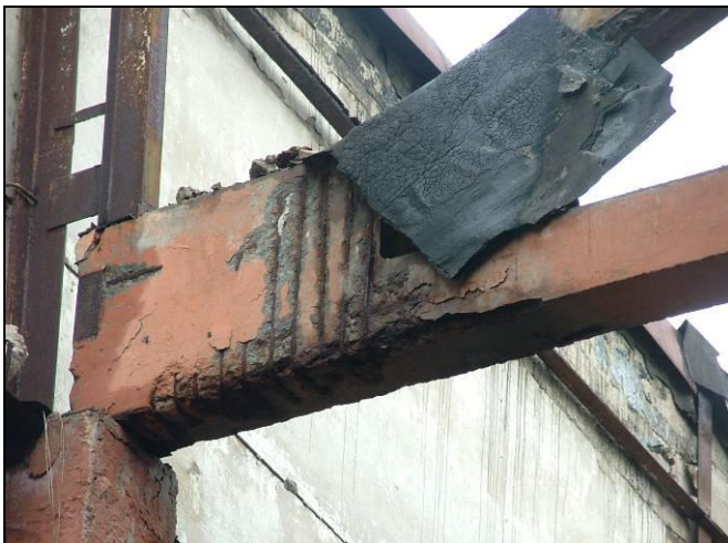
Рисунок 6.18 – Фрагмент опорной зоны железобетонной фермы покрытия
