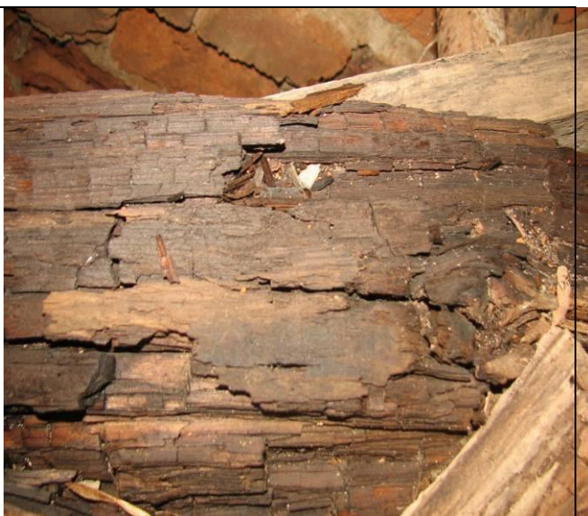
Рисунок 6.24 – Фрагмент лежня
