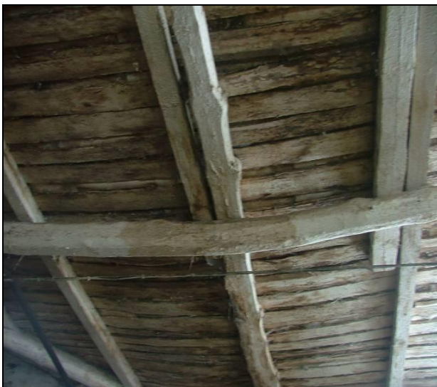
Рисунок 6.22 – Фрагмент покрытия по деревянным балкам
