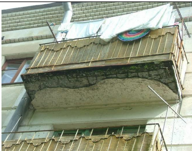
Рисунок 6.28 – Фрагмент сборной железобетонной балконной плиты
