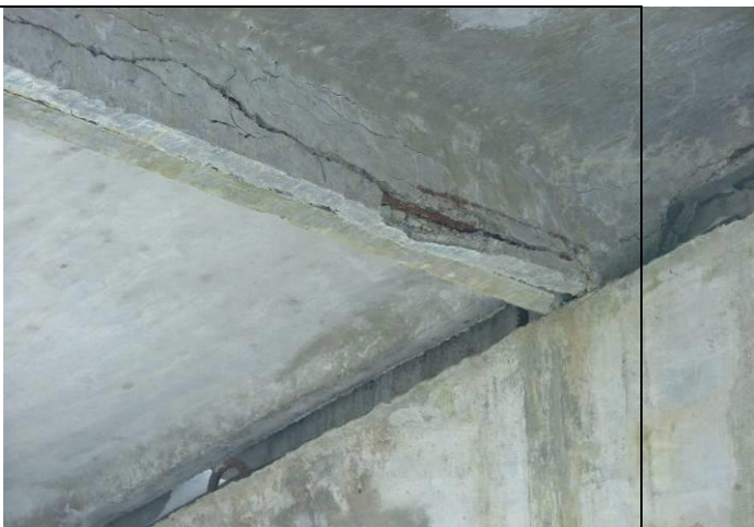
Рисунок 6.20 – Фрагмент железобетонных ребристых плит покрытия
