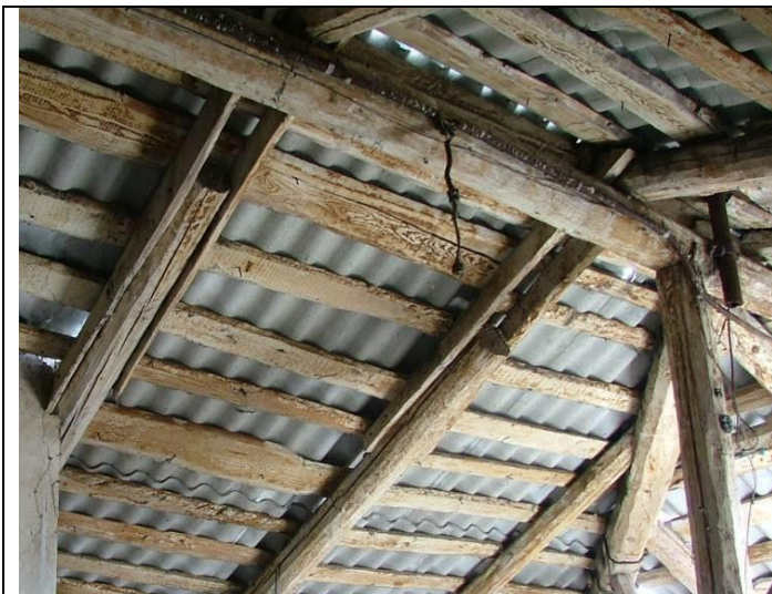
Рисунок 6.7 – Фрагмент стропильной системы
