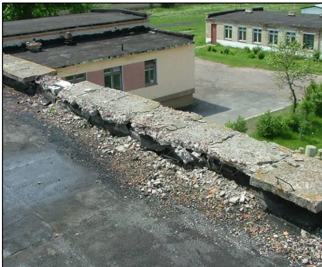
Рисунок 6.26 – Фрагмент парапетных железобетонных плит
