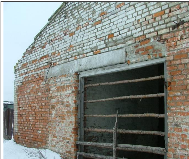
Рисунок 6.3 – Фрагмент железобетонного прогона
