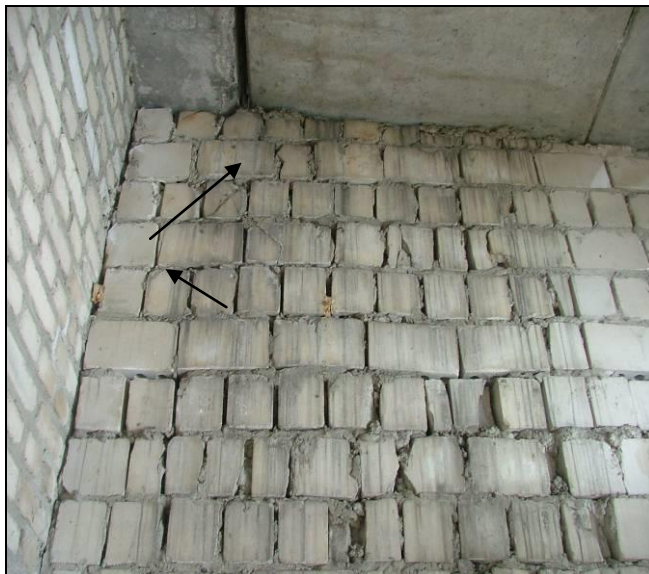
Отклонение плиты от горизонтали на величину до 40 мм
