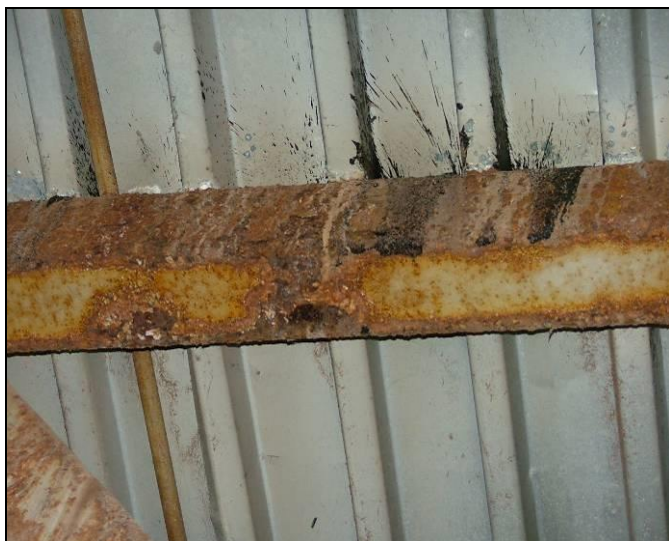
Рисунок 6.19 – Фрагмент верхнего пояса стальной фермы
