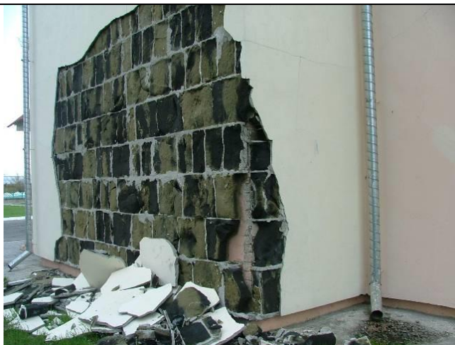
Рисунок 6.13 – Фрагмент наружной стены с выполненной термореновацией
