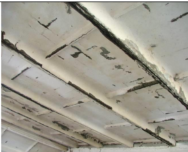
Рисунок 6.21 – Фрагмент железобетонных ребристых плит покрытия
