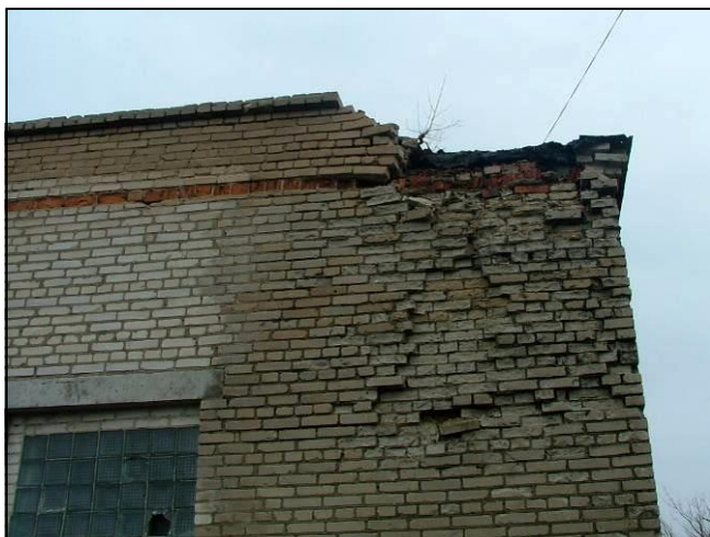
Рисунок 6.11 – Фрагмент верхней части наружной кирпичной стены
