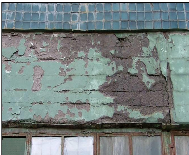
Рисунок 6.15 – Фрагмент наружной стены, выполненной из стеновых панелей
