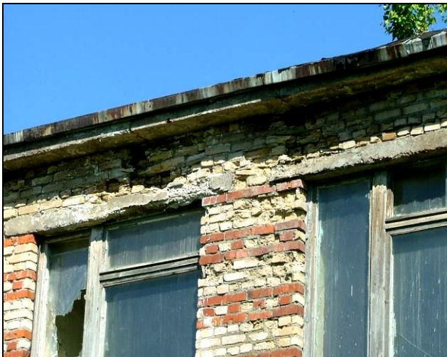
Рисунок 6.10 – Фрагмент наружной кирпичной стены
