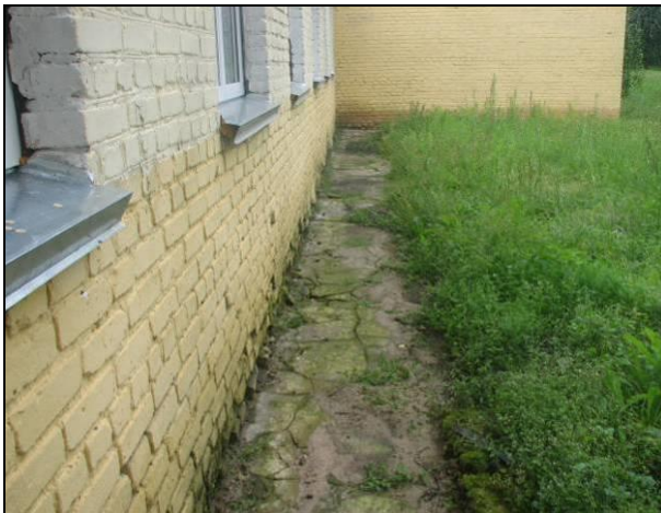
Рисунок 6.30 – Фрагмент отмостки
