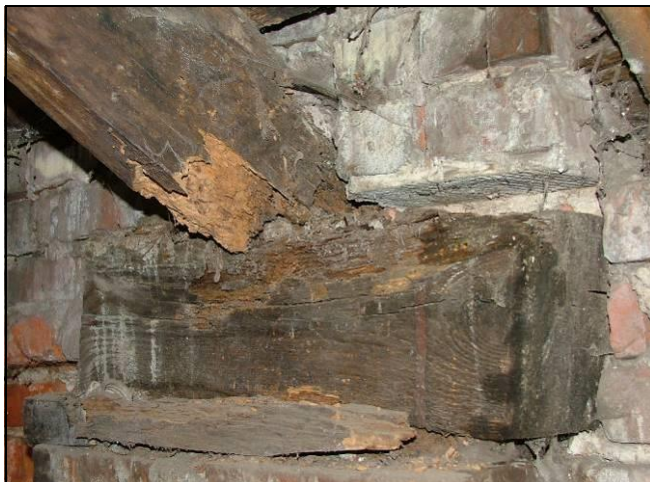
Рисунок 6.23 – Фрагмент стропильной ноги и мауэрлата
