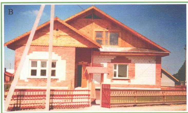
Опоры линий электропередачи, размещенные перед домом, ухудшают восприятие архитектурного решения дома
