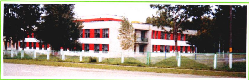
А – дворец культуры в населенном пункте Судкова Хойникского района; Б – торговый центр в населенном пункте Горочичи Калининковского района; В – культурное сооружение в населенном пункте Красное Гомельского района; Г – школа в населенном пункте Носовичи Добрушского района
