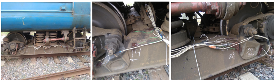
Рисунок 3 – Установленные на раме тележки датчики деформаций
