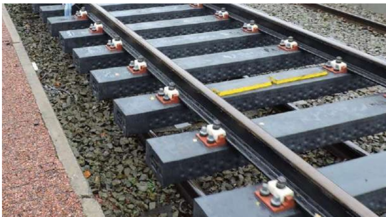
Рисунок 2 – Применение ПКМ для изготовления шпал
