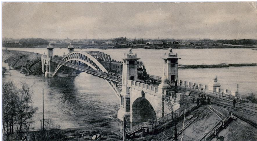
Сергиевский железнодорожный мост
