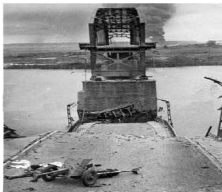
Разрушенный мост через р. Сож в г. Гомеле, 1941 год
