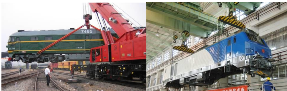
Рисунок 21.1 – Подъем кузова электровоза при помощи кранов
