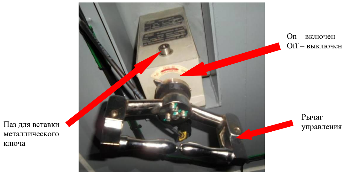
Рисунок 19.8 – Высоковольтный разъединитель QS-HV
