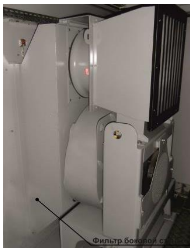
Рисунок 8.2 – Место установки фильтра очистки воздуха
