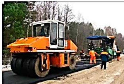
Рисунок 11 – Процесс укладки горячей асфальтобетонной смеси с пониженной температурой приготовления и укладки
