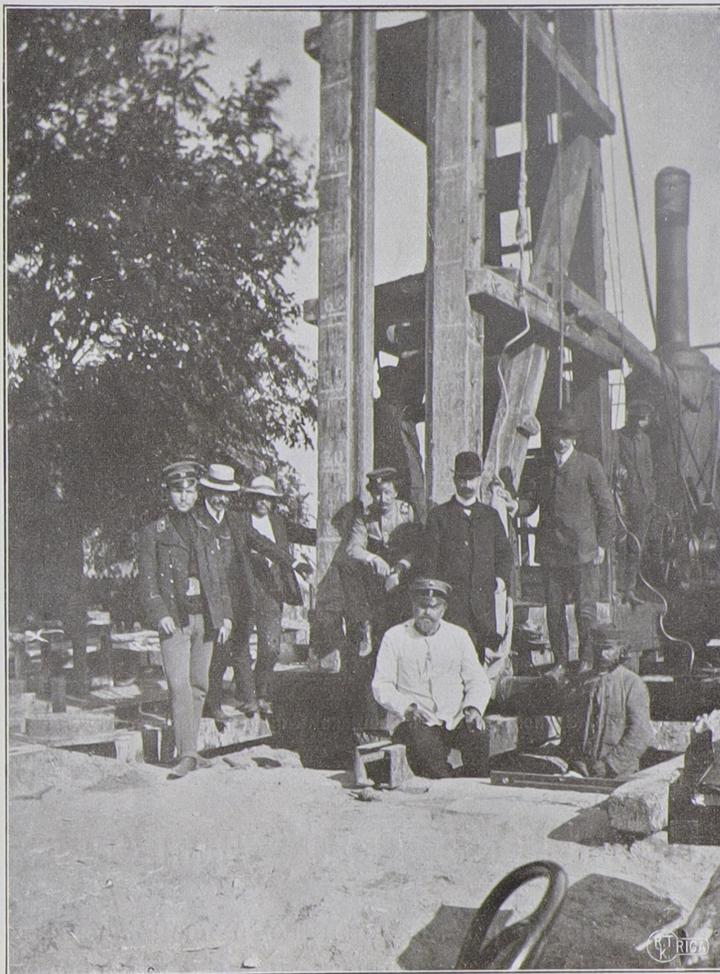
Фиг. 7. Коперъ Симплексъ на работахъ по устройству основаній подъ устой виадука въ Брестъ-Литовскѣ.
