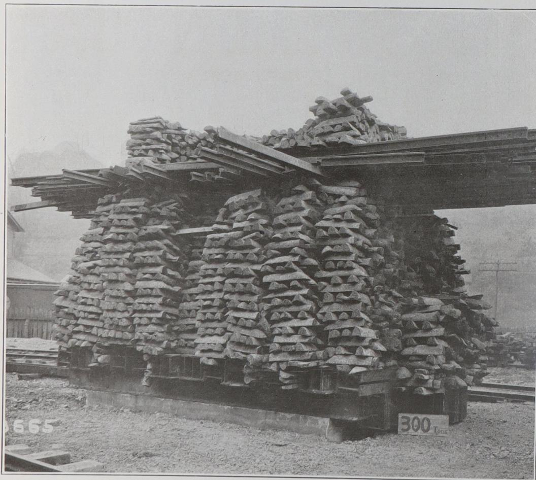
Фиг. 40. Пробная нагрузка на 5 свай въ 300 тоннъ.
