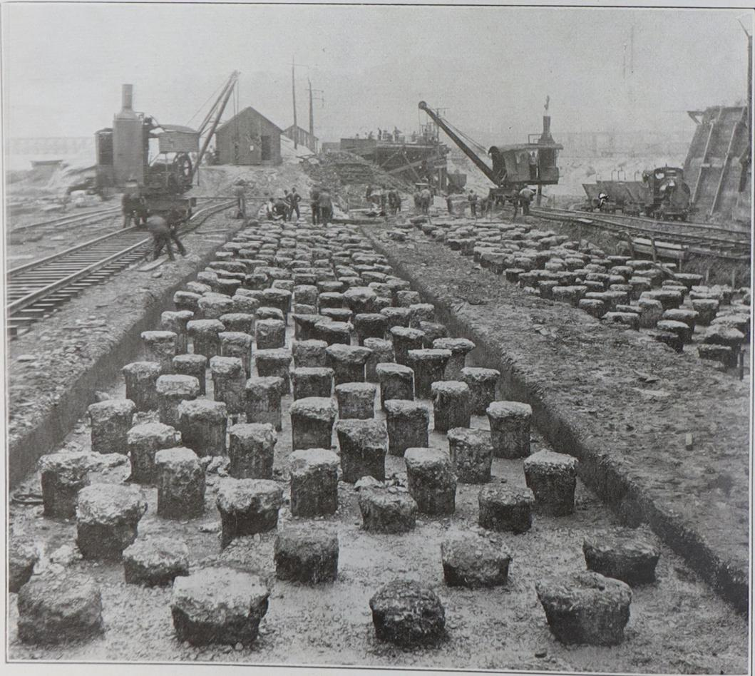
Фиг. 27. Головы свай передь бетонированіемъ подушки. Сталелитейный заводъ въ Америкѣ.
