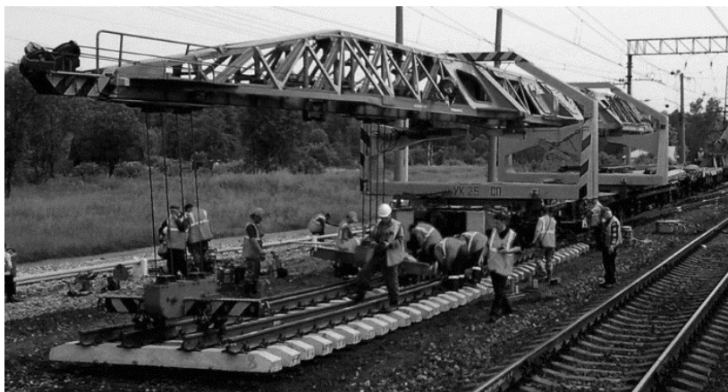
Рисунок 1.28 – Путьукладочный кран для замены стрелочных переводов УК-25СП
