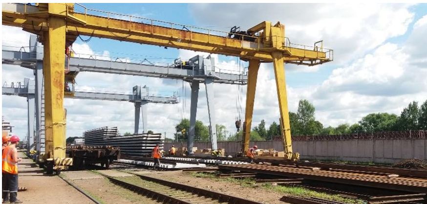
Рисунок 2.3 – Производственная база путевой машинной станции. Стенд сборки звеньев рельсошпальной решетки
