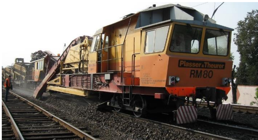
Рисунок 1.31 – Работа щебнеочистительной машины RM-80 UHR
