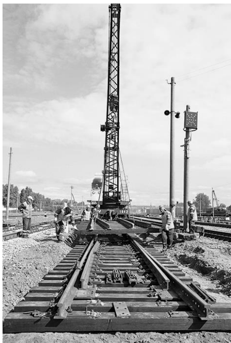
Рисунок 1.30 – Замена стрелочного перевода стреловым краном
