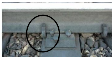
Рисунок 1.12 – Правильное положение противоугона относительно шпалы
