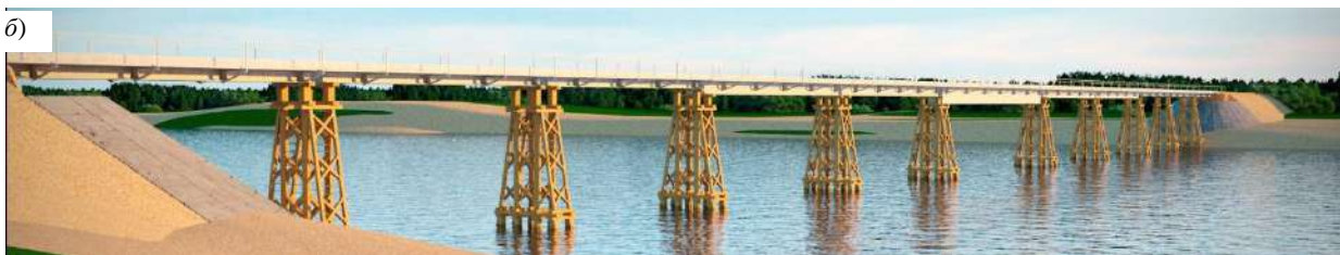
Рисунок 2 – Варианты схем железнодорожного моста на ближнем обходе: а – краткосрочный низководный; б – временный высоководный
