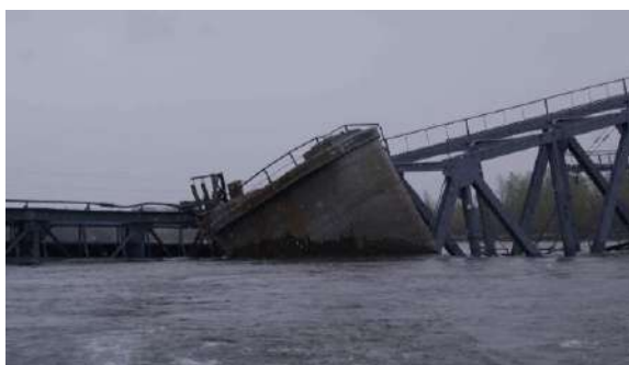
Рисунок 1 – Обрушение больших железнодорожных мостов вследствие подмыва русловых опор: а – через реку Абакан в Республике Хакасия (май 2011 г.); б – через реку Кола в Кольском районе Российской Федерации (июнь 2020 г.)
