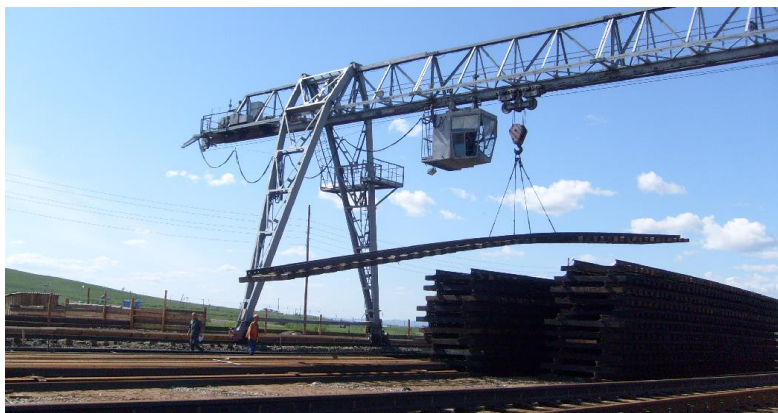
Рисунок 2.3 – Перегрузка готового звена козловым краном
