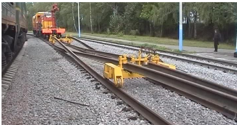
Рисунок 9.10 – Схема замены инварных рельсов плетями бесстыкового пути с применением роликовых салазков
