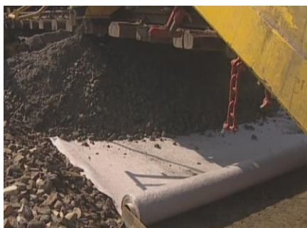
Рисунок 7.15 – Укладка защитного слоя на основную площадку
