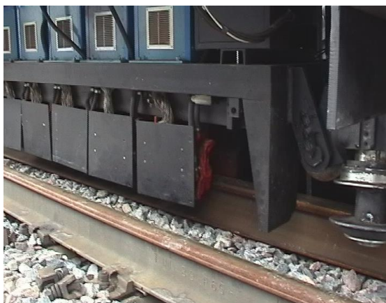
Рисунок 9.13 – Нагрев рельсовых плетей, выгруженных в середину колеи
