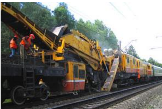
Рисунок 7. 6 – Щебнеочистительная машина СЧ-601
