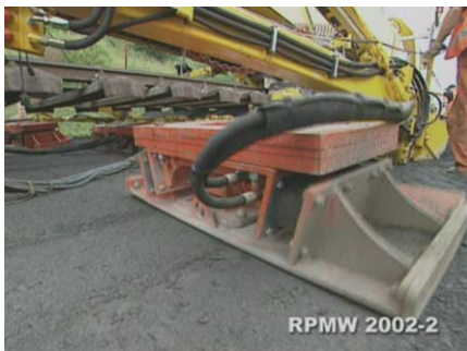
Рисунок 7.16 – Уплотнение песчано-гравийной смеси
