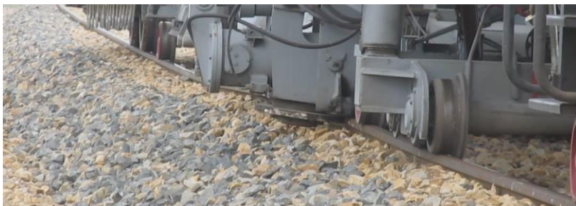
Рисунок 6.5 – Подъем пути электромагнитным подъемником
