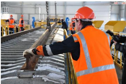
Рисунок 2.13 – Участок укладки рельсов
