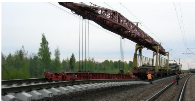
Рисунок 4.1 – Укладка звеньев путеукладочным краном УК 25/9-18
