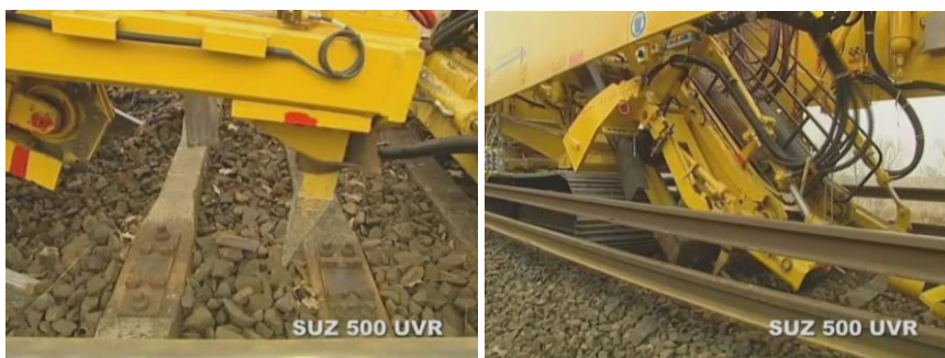
Рисунок 4.7 – Устройство для уборки старых шпал комплекса SUZ 500 UVR
