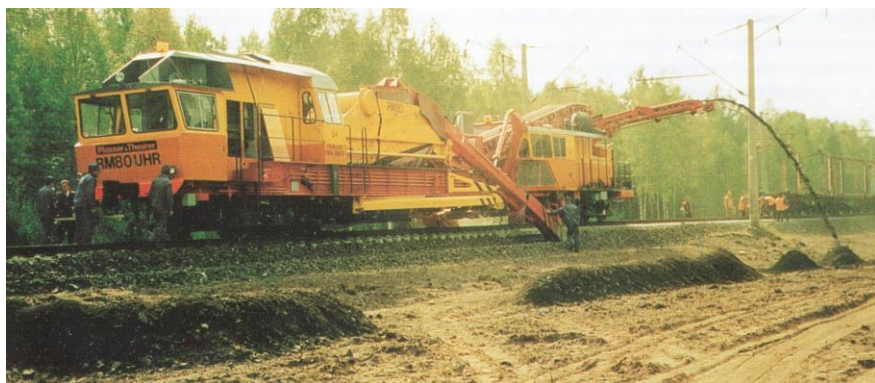
Рисунок 7. 8 – Работа щебнеочистительной машины RM-80 UHR с отсыпкой засорителя на обочину
