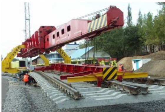
Рисунок 4.15 – Укладочный кран повышенной грузоподъемности УК-25/28СП
