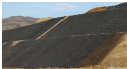
Рисунок 2 – Укрепление откосов высокой насыпи геоматами
