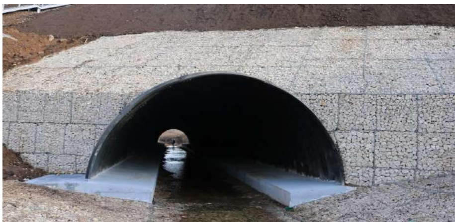
Рисунок 1 – Многофункциональная водопропускная труба под земляным полотном железнодорожного пути
