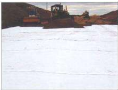
Рисунок 1 – Укладка геосинтетических материалов в слоях дорожной одежды
