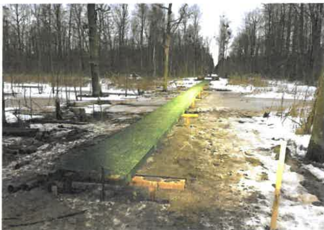
Рисунок 4 – Установка главных балок и пешеходного настила
