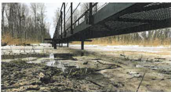
Рисунок 7 – Эксплуатация моста на структурно-неустойчивых грунтах с применением малогабаритного сборно-разборного мостового пролета
