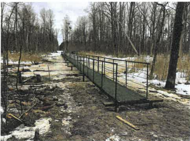
Рисунок 5 – Установка перильного ограждения
