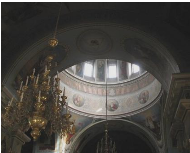
Рисунок 2 – Центральная ячейка собора св. Петра и Павла (цилиндрические своды, паруса, световой барабан)
