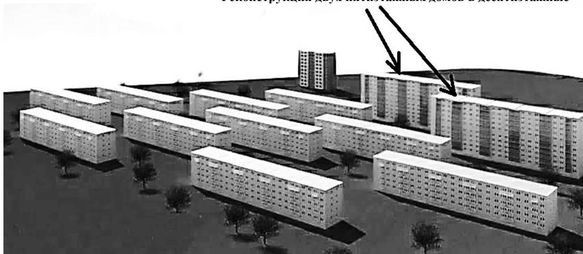
Рисунок 4.5 – Реконструкция двух пятиэтажных домов с наращиванием пяти этажей
