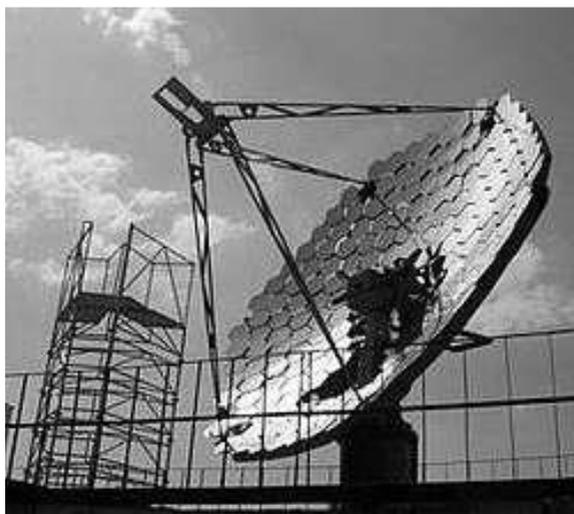
Рисунок 3.18 – Параболоидная гелиоустановка с концентратором
