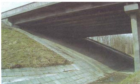
Рисунок 1.59 – Защита земляного полотна от эрозии укреплением откосов подмостовых конусов бетонными плитами [34]
