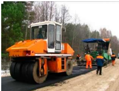
Рисунок 1.49 – Процесс укладки горячей асфальтобетонной смеси с пониженной температурой приготовления и укладки
