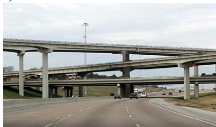
Рисунок 2.31 – Автодорожный путепровод: а – простой двухуровневый; б – многоярусный
