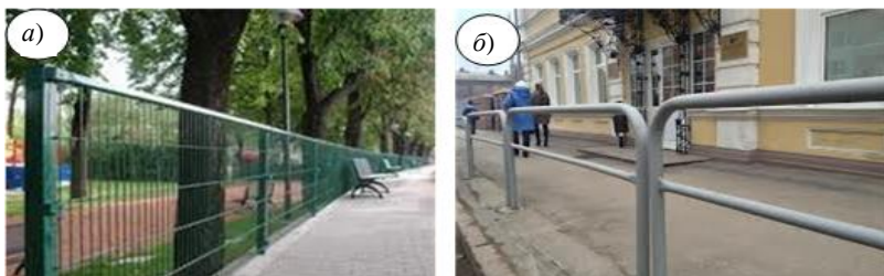
Рисунок 1.92 – Пешеходные ограждения: а – удерживающие, б – ограничивающие
