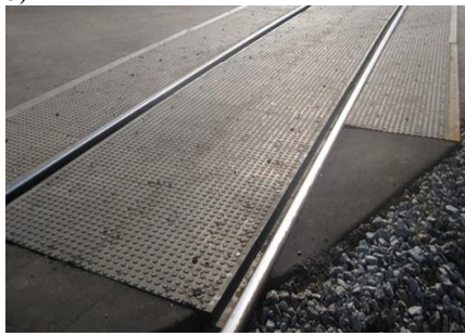
Рисунок 3.34 – Настилы на железнодорожных переездах: а – из сборного железобетона; б – резинокордовый
