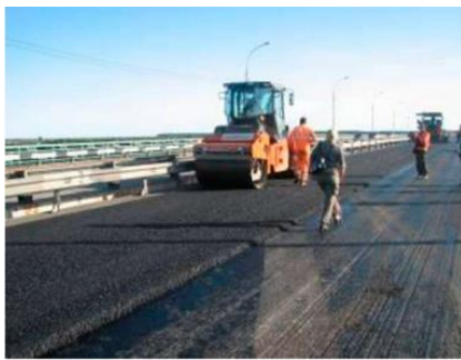
Рисунок 1.44 – Процесс укладки покрытия из асфальтобетонной смеси с резиновой крошкой
