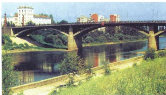
Рисунок 2.12 – Арочный мост через реку Западная Двина в г. Витебске [55]
