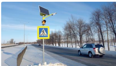
Рисунок 1.94 – Комплект освещения пешеходного перехода со светофором Т.7 на солнечных батареях STGM-95/65
