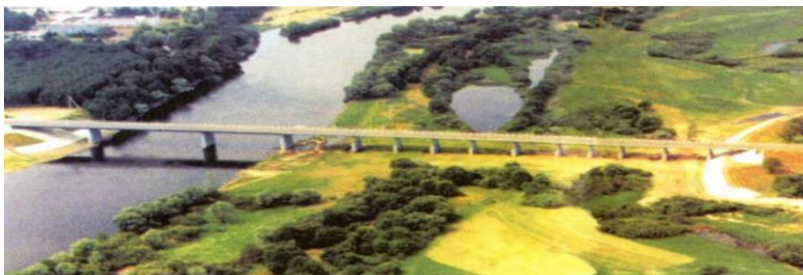
Рисунок 2.4 – Мостовой переход через р. Березина у г. Светлогорска [55]
