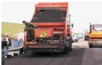
Рисунок 1.53 – Распределение обработанного вяжущим щебня фракции от 5 до 10 мм и его последующее втапливание с помощью гладковальцового катка
