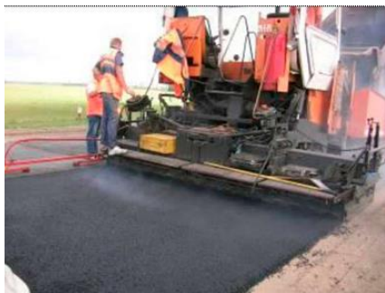
Рисунок 1.44 – Процесс укладки покрытия из асфальтобетонной смеси с резиновой крошкой
