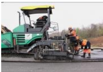
Рисунок 1.52 – Процесс укладки жесткой вибролитой асфальтобетонной смеси
