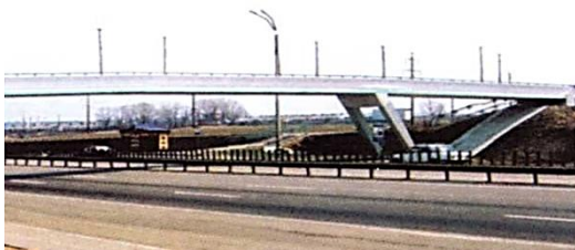
Рисунок 2.32 – Путепровод автомагистрали с городской улицей и рамной системой [55]
