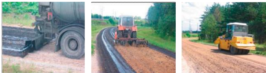
Рисунок 1.51 – Процесс нанесения эмульсии, обеспыливающей гравийное покрытие автомобильных дорог
