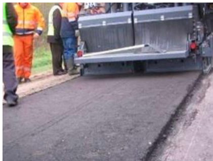
Рисунок 1.48 – Процесс укладки покрытий из холодных регенерированных асфальтобетонных смесей по технологии холодного ресайклинга
