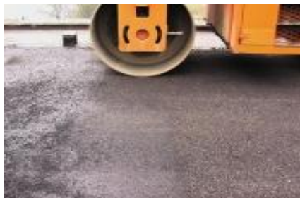
Рисунок 1.53 – Распределение обработанного вяжущим щебня фракции от 5 до 10 мм и его последующее втапливание с помощью гладковальцового катка
