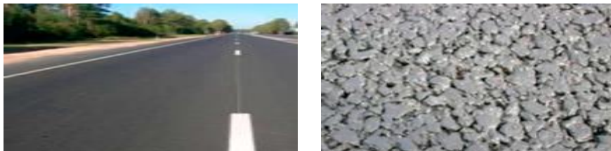
Рисунок 1.50 – Вид готового покрытия с использованием щебеночно-мастичных асфальтобетонных смесей с применением целлюлозного волокна
