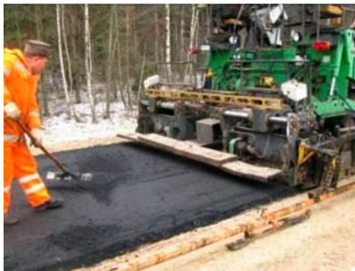
Рисунок 1.49 – Процесс укладки горячей асфальтобетонной смеси с пониженной температурой приготовления и укладки
