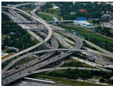
Рисунок 1.9 – Внешний вид городской скоростной автомобильной дороги в городах
