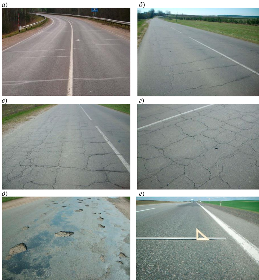
Рисунок 1.35 (начало) – Дефекты покрытия нежестких дорожных одежд капитального и облегченного типов [25]:
