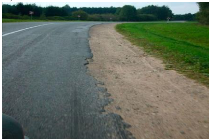
Рисунок 1.35 (продолжение) – Дефекты покрытия нежестких дорожных одежд капитального и облегченного типов [25]:
