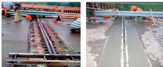
Рисунок 1.58 – Устройство деформационного шва и вид готового шва
