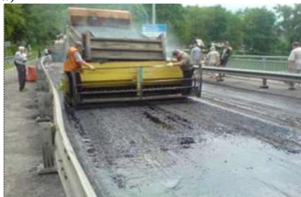
Рисунок 1.55 – Процесс укладки покрытия: а – по мембранной технологии; б – вид готового покрытия
