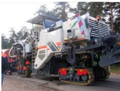
Рисунок 1.48 – Процесс укладки покрытий из холодных регенерированных асфальтобетонных смесей по технологии холодного ресайклинга
