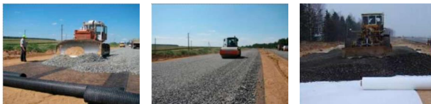
Рисунок 1.41 – Процесс укладки прослойки из геосинтетических материалов
