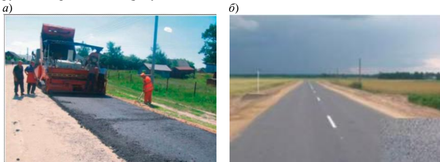
Рисунок 1.46 – Процесс укладки ЭМС: а – с ускоренным сроком формирования; б – вид готового покрытия
