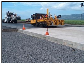
Рисунок 1.3 – Укладка цементобетонной дороги
