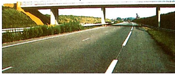
Рисунок 2.33 – Путепровод через автомобильную дорогу балочно-неразрезной [55]
