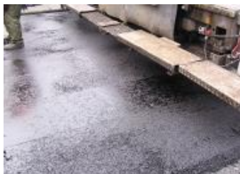
Рисунок 1.52 – Процесс укладки жесткой вибролитой асфальтобетонной смеси
