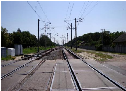
Рисунок 3.34 – Настилы на железнодорожных переездах: а – из сборного железобетона; б – резинокордовый
