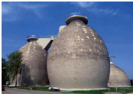
Рисунок 6.8 – Конструкции метантенков: а – яйцевидная форма; б – цилиндрическая форма
