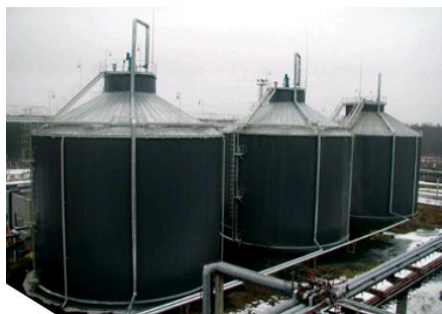
Рисунок 6.8 – Конструкции метантенков: а – яйцевидная форма; б – цилиндрическая форма
