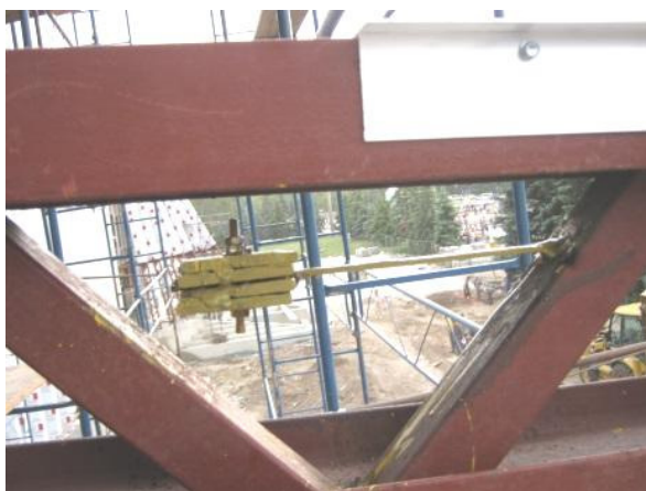
Рисунок 6 – Установленный гаситель на конструкции фермы
