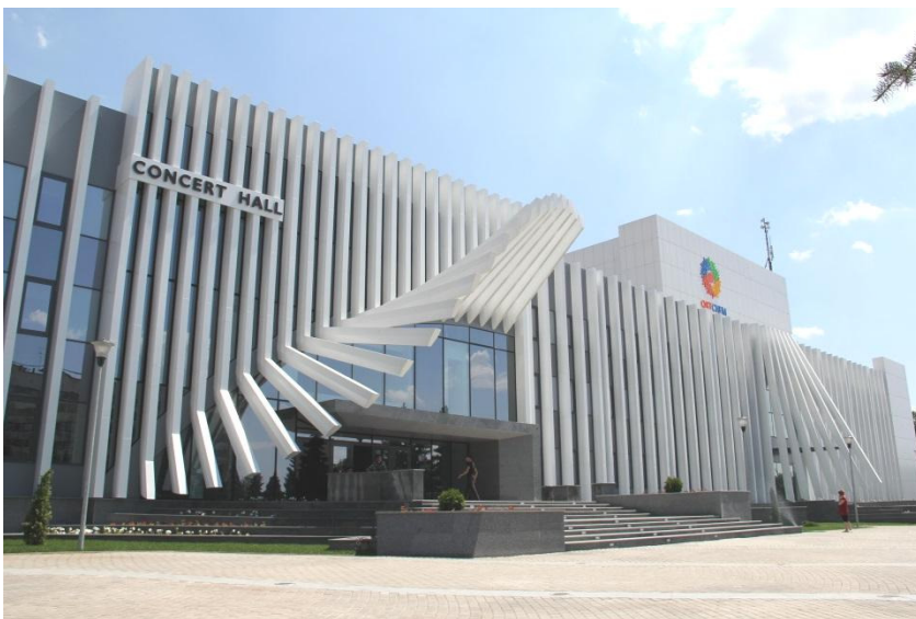
Рисунок 1 – Общий вид здания после реконструкции (фасад 1-19)
