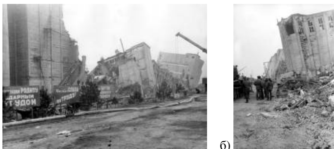
Рисунок 1 – Последствия землетрясения в Спитаке: а – наклон зданий в противоположные стороны; б – наклон и разворот здания
