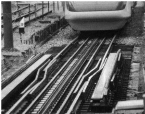
Рисунок 8.3 – Общий вид установки
