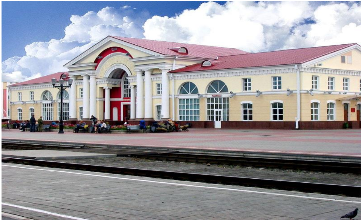
Рисунок А.4 – Современное здание железнодорожного вокзала в Полоцке
