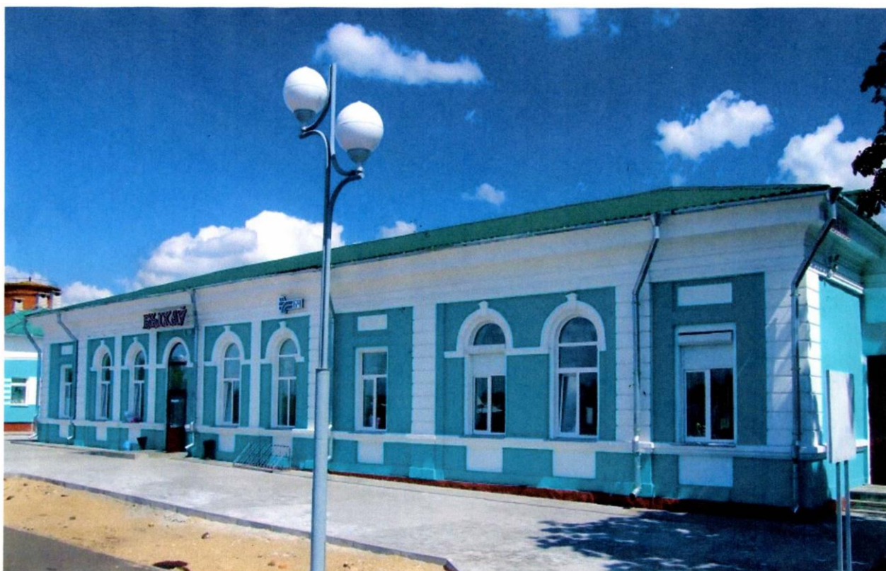
Рисунок 3.1 – Станционное здание в г. Быхове
