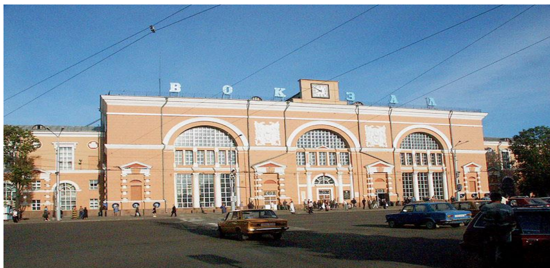
Рисунок А.6 – Современный вид железнодорожного вокзала в Витебске
