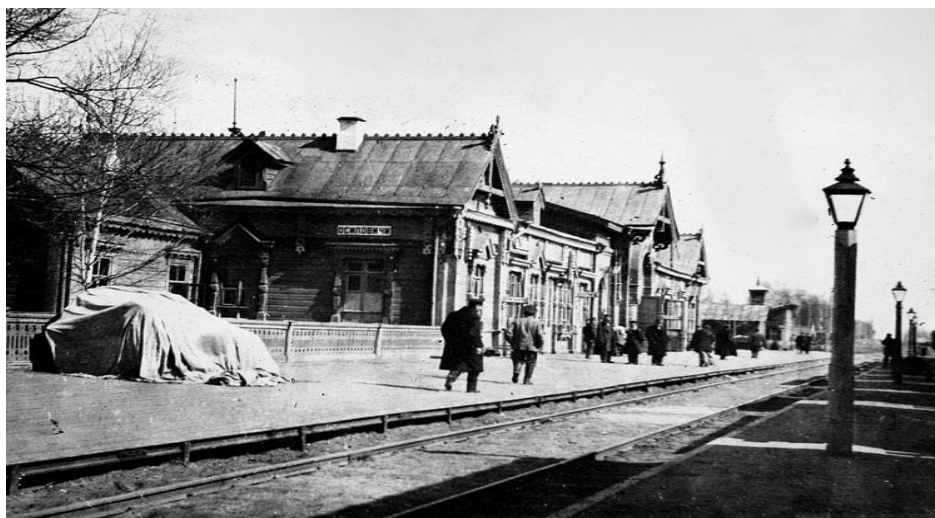
Рисунок А.25 – Историческое здание железнодорожного вокзала в Осиповичах
