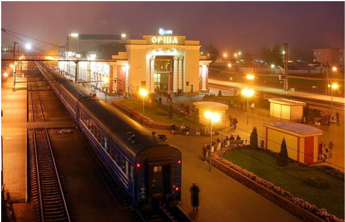
Рисунок А.9 – Современный вид железнодорожного вокзала в Орше со стороны платформы
