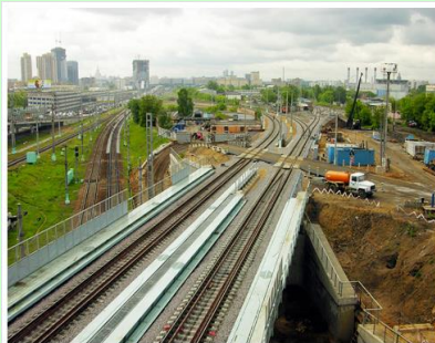
Рисунок 4.33 – Путепровод над железнодорожными путями
