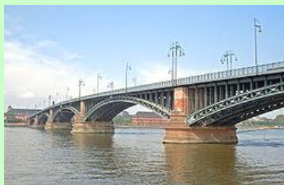
Рисунок 4.6 – Внешний вид металлического балочного моста
