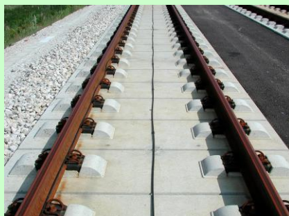
Рисунок 4.34 – Рельсы, уложенные на плиты
