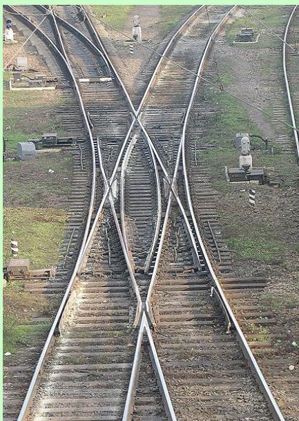
Рисунок 4.36 – Перекрестный стрелочный перевод
