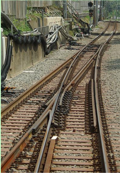
Рисунок 4.37 – Стрелочный перевод с подвижным сердечником
