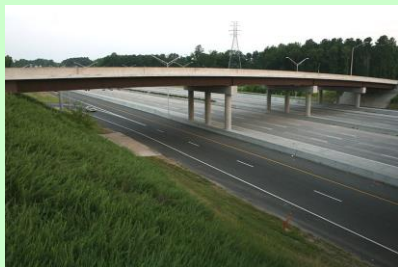
Рисунок 4.16 – Автодорожный простой путепровод
