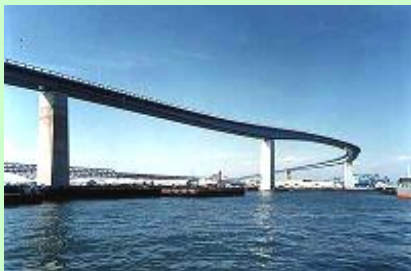
Рисунок 4.7 – Внешний вид трехпролетного балочного моста
