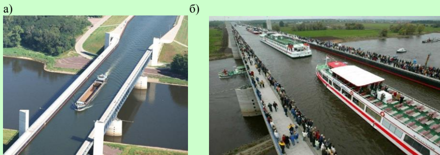
Рисунок 4.44 – Путепроводные развязки водного транспорта: а – для грузового и технологического транспорта; б – для туристического транспорта
