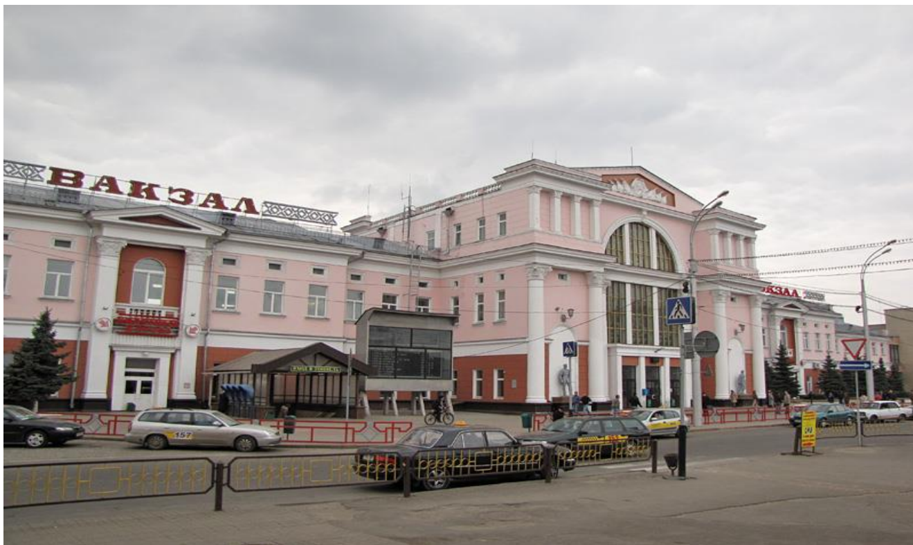
Рисунок 5.1 – Железнодорожный вокзал станции Гомель
