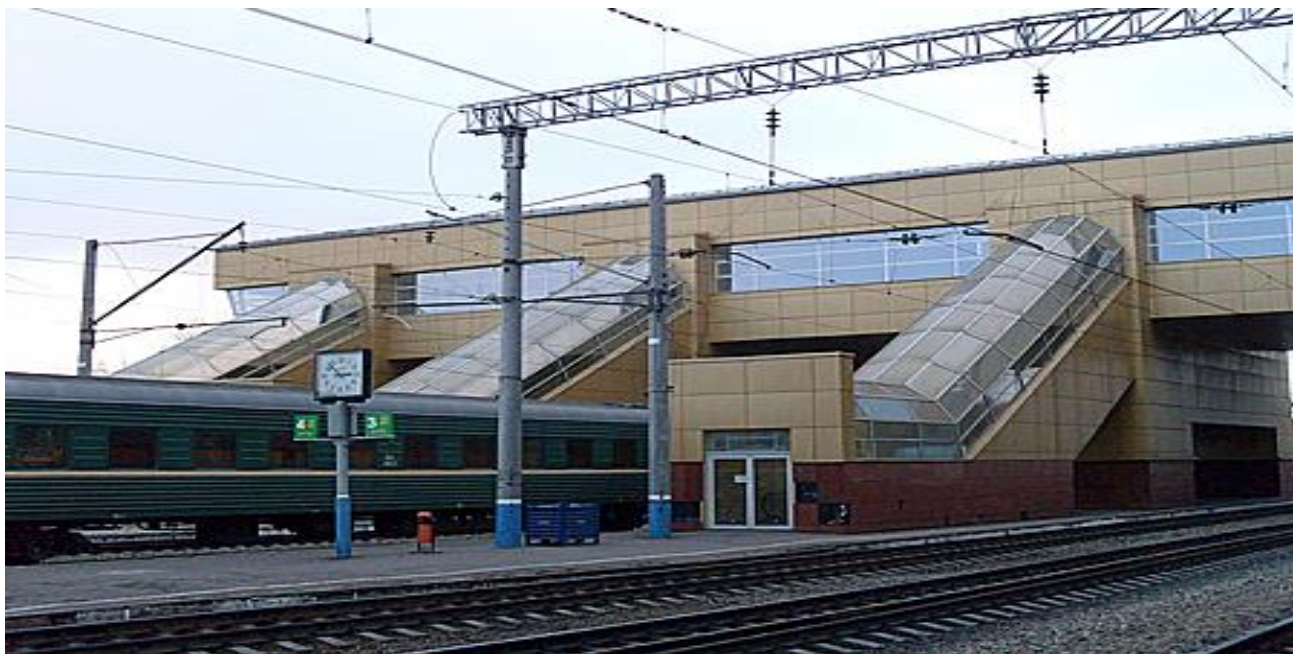
Рисунок 3.3 – Конкорс пассажирского здания вокзала станции Минск
