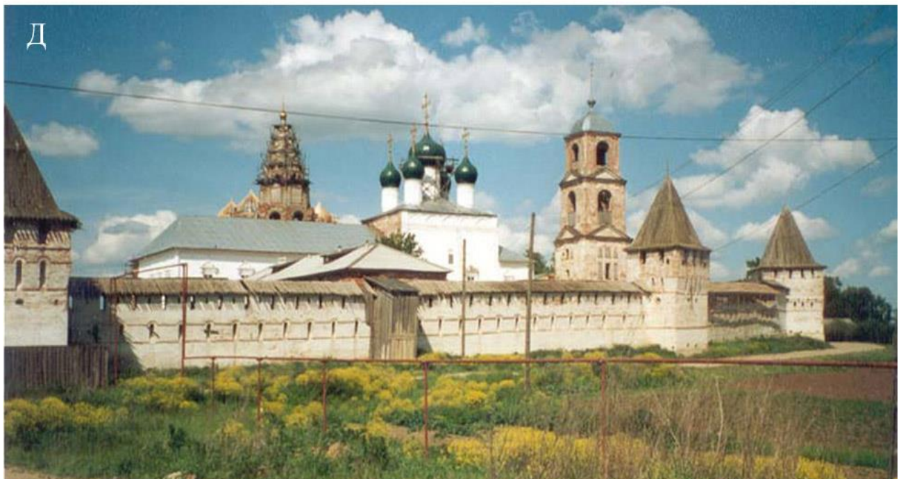
Рисунок 2.14 – Никитский монастырь в Переславле-Залесском: А – общий вид монастыря; Б-Г – башни и стены монастыря; Д – вид с юго-запада.
