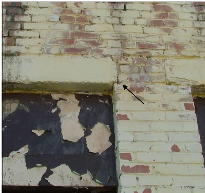
Рисунок А.42 – Фрагмент ж/б перемычек
