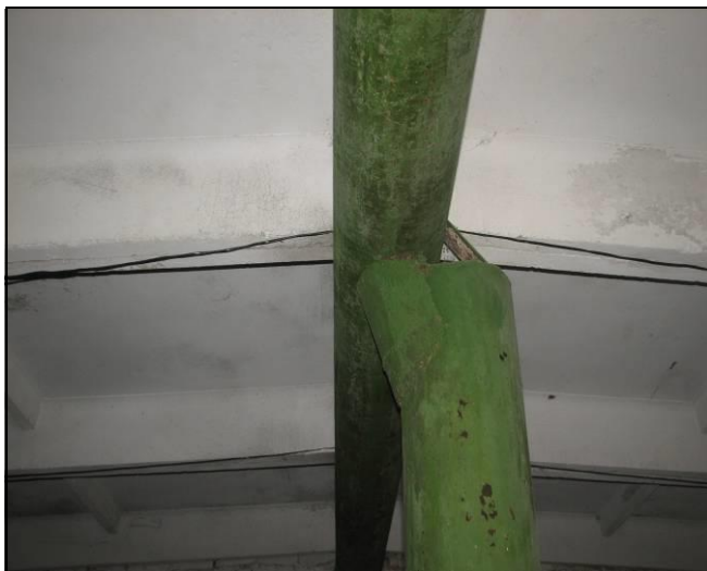
Рисунок А.37 – Фрагмент узла опирания стального прогона на стальную стойку
