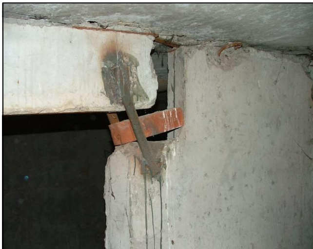
Применение стеновых панелей не соответствующих типоразмеров для их стыковки в районе дверного проема (стеновая панель слева не опирается на панель, расположенную справа, зазоры между панелями по вертикали и горизонтали составляют до 100 мм, стыковка выполнена через стальные пластины)
