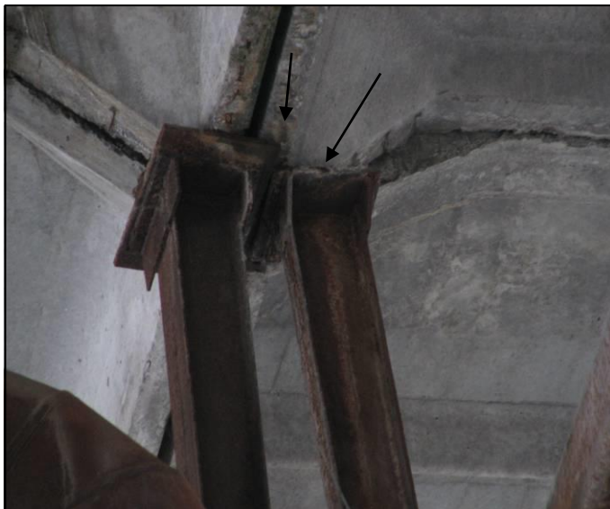
Рисунок А.70 – Фрагмент узла опирания ребристых плит
