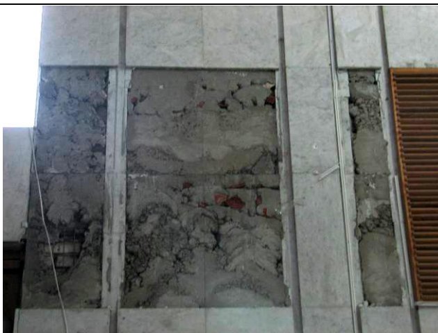
Рисунок А.20 – Фрагмент облицовки наружной кирпичной стены со стороны помещения
