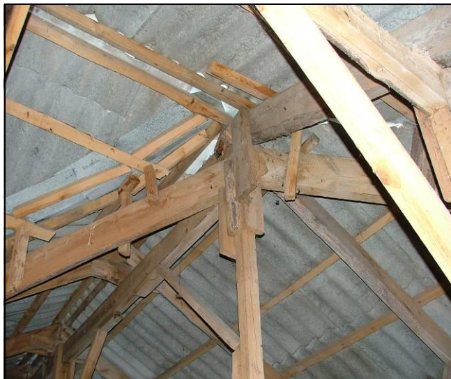
Выполнение стропильной системы и обрешетки кровли из фрагментов и обрезков пиломатериалов (брусков, досок)
