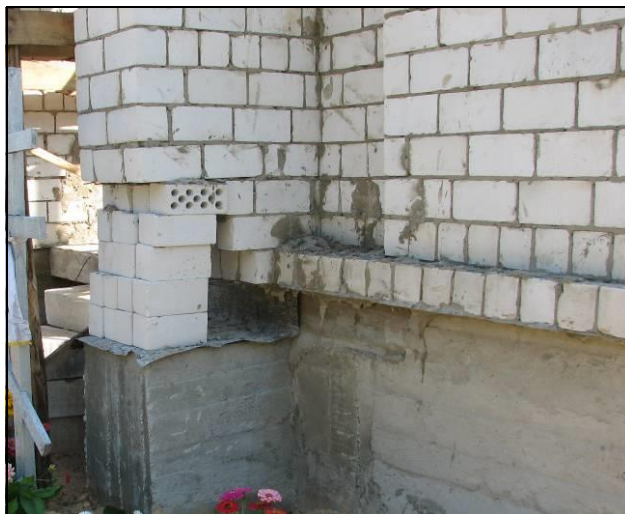
Отсутствие участка кладки в нижней части пилястры и выполнение на данном участке «подпорки» из кирпичей силикатных утолщенных без применения кладочного раствора
