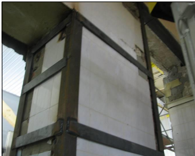
Рисунок А.38 – Фрагмент столба, усиленного стальной обоймой
