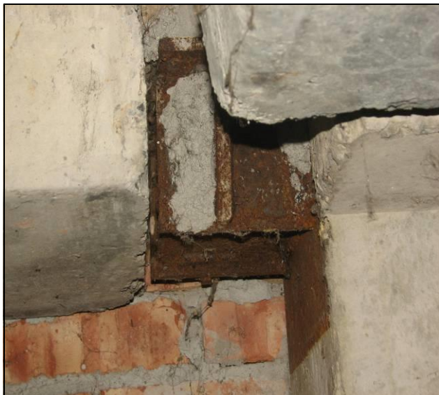
Рисунок А.50 – Фрагмент опорного столлика на участке стыковки ригеля и колонны
