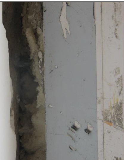
Рисунок А.113 – Фрагмент оконного блока ПВХ
