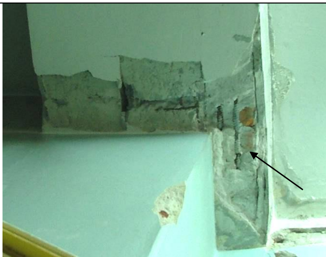
Рисунок А.56 – Фрагмент прогона междуэтажного перекрытия
