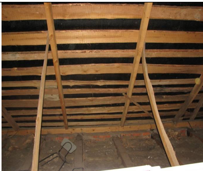
Рисунок А.83 – Фрагмент стропильной системы
