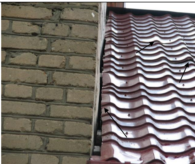
Отсутствие фартука на участке примыкания кровли к наружной стене; смещение фрагментов металлочерепицы относительно друг друга; неплотное прилегание листов металлочерепицы друг к другу на отдельных участках
