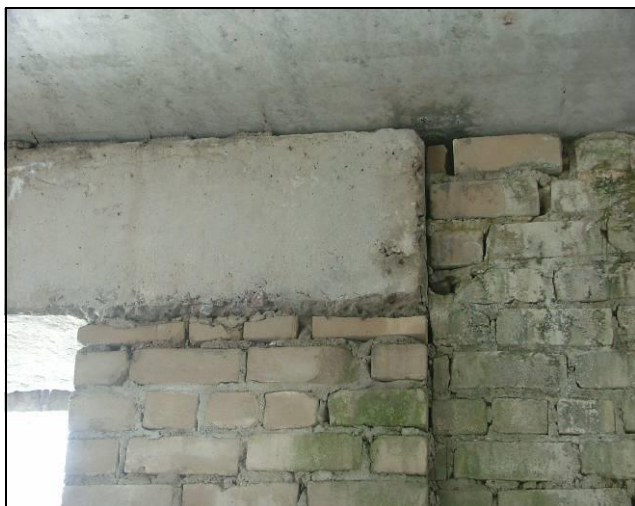
Рисунок А.30 – Фрагмент стены, выполненной из кирпича силикатного
