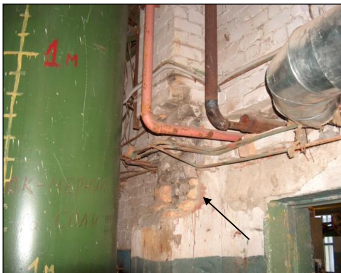
Механическое разрушение участка кладки в средней части на всю толщину и ширину пилястры для пропуска коммуникаций
