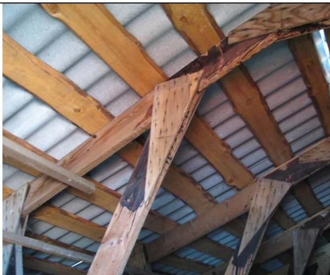
Рисунок А.84 – Фрагмент стропильной системы
