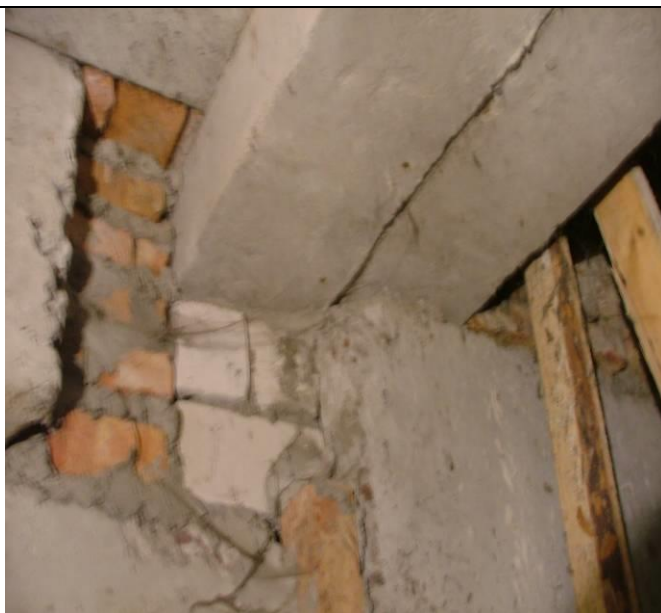
Рисунок А.23 – Фрагмент стены на участке опирания прогонов
