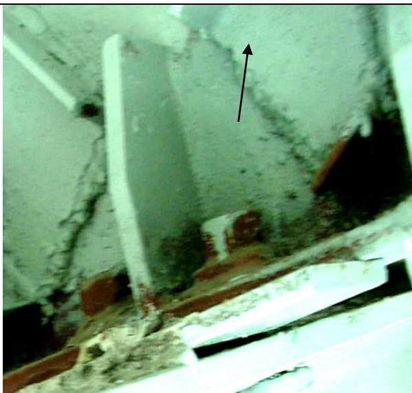
Рисунок А.79 – Фрагмент узла крепления раскоса подвесного транспорта (рельс-балки) к ферме покрытия
