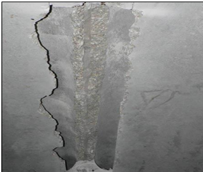
Рисунок А.58 – Фрагмент плиты перекрытия пустотного настила типа ПК
