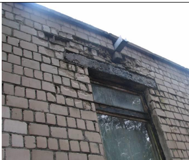
Организация водоотвода с кровли через отверстие в парапетной части наружной стены с устройством желоба длиной до 300 мм
