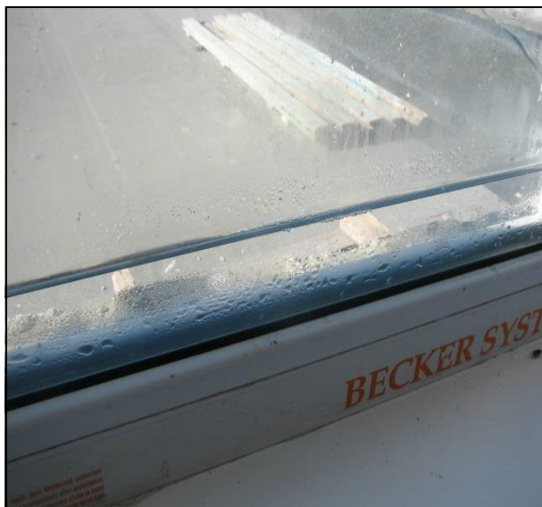
Рисунок А.114 – Фрагмент оконного блока ПВХ
