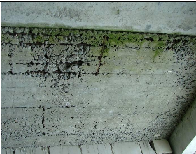
Рисунок А.64 – Фрагмент плиты перекрытия пустотного настила
