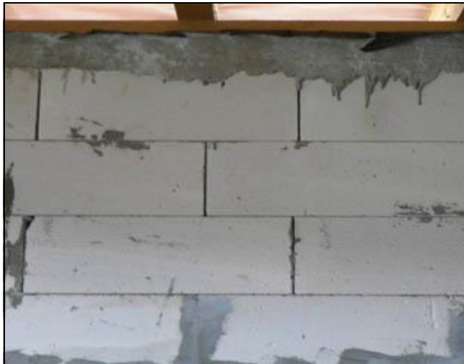
Рисунок А.13 – Фрагмент кладки стены из блоков ПГС
