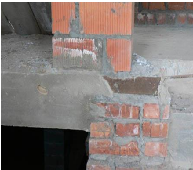
Рисунок А.36 – Фрагмент кирпичного столба и внутренней несущей стены
