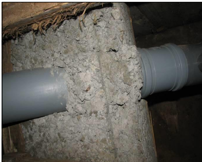
Рисунок А.5 – Фрагмент столбчатого монолитного бетонного фундамента
