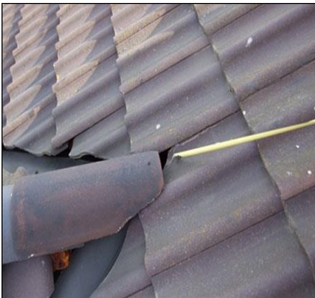
Некачественная стыковка конькового элемента черепицы крыши пристройки с основным скатом крыши
