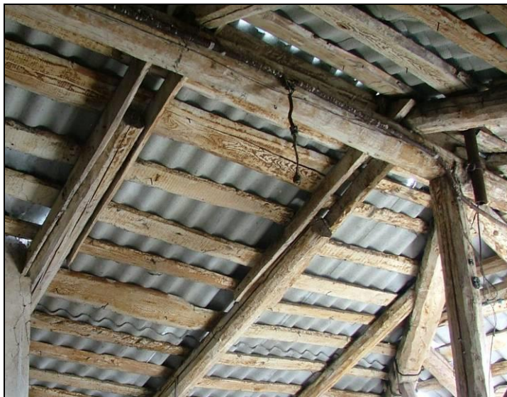
Рисунок А.86 – Фрагмент стропильной системы
