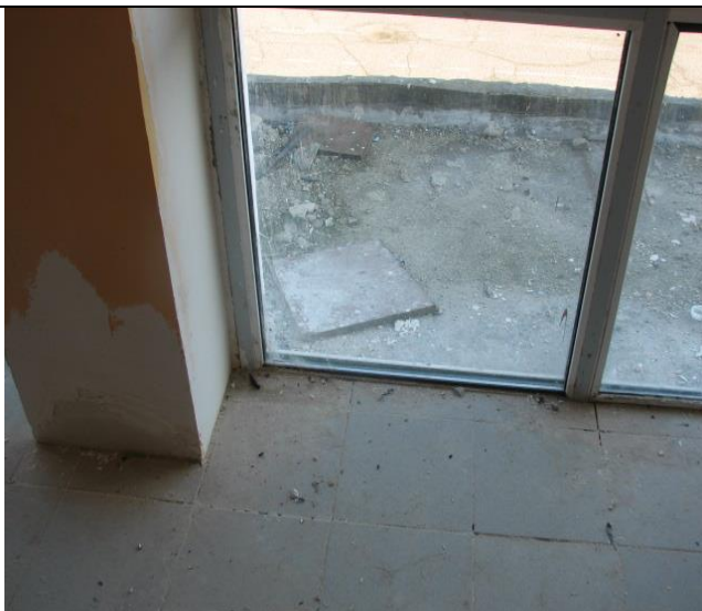
Рисунок А.112 – Фрагмент оконного блока ПВХ
