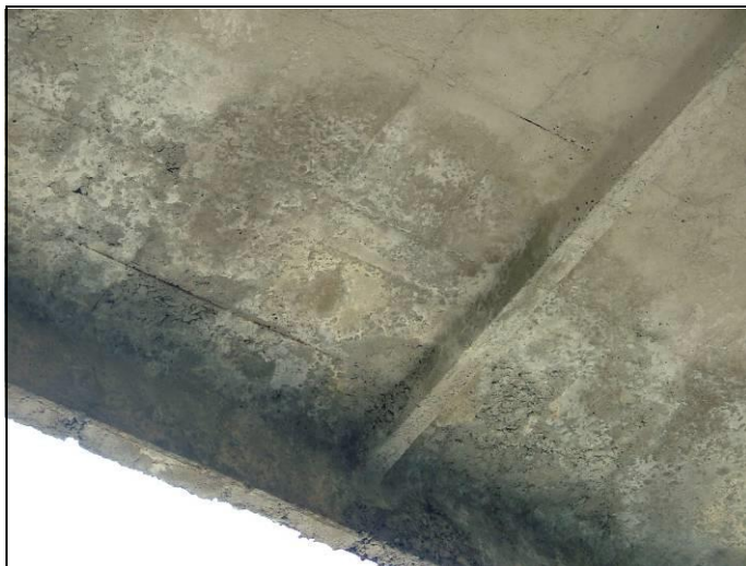
Рисунок А.66 – Фрагмент ж/б ребристой плиты покрытия
