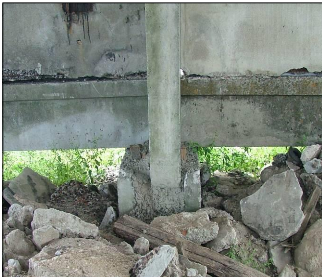
Рисунок А.6 – Фрагмент фундамента под полураму
