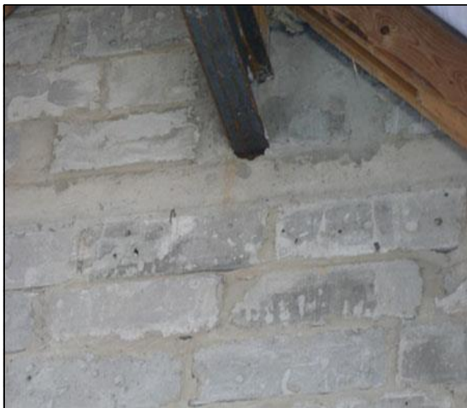
Отсутствие ж/б опорной подушки либо опорной стальной пластины под балкой для предотвращения смятия камня
