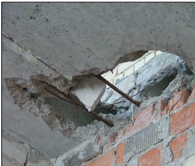
Механическое разрушение бетона опорных участков плит на всю толщину с оголением стержней рабочей арматуры (длина участков до 400 мм)
