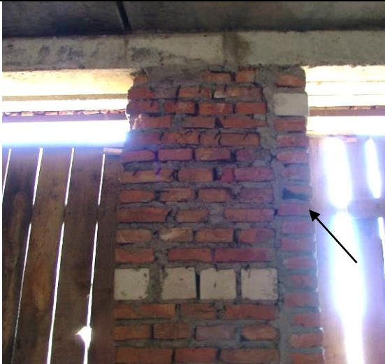
Рисунок А.14 – Фрагмент простенка наружной кирпичной стены
