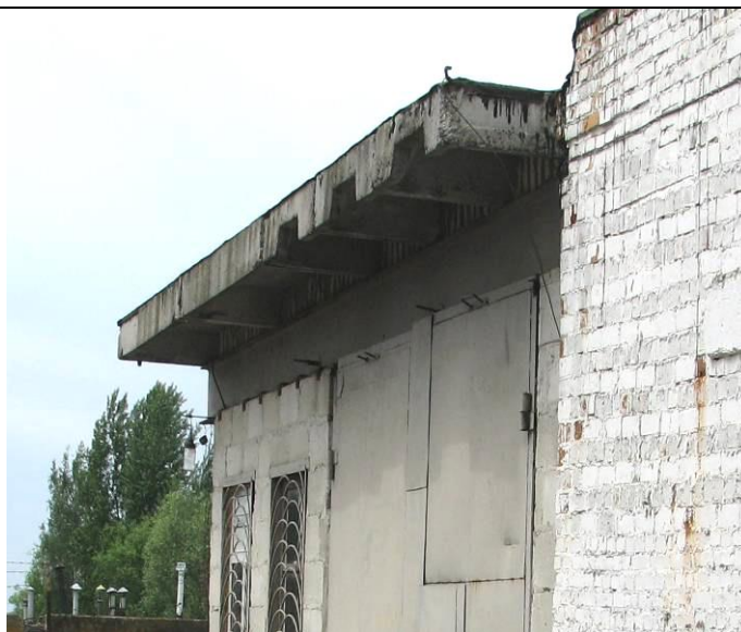
Рисунок А.67 – Фрагмент покрытия пристройки
