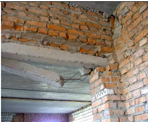
Рисунок А.47 – Фрагмент дверной перемычки
