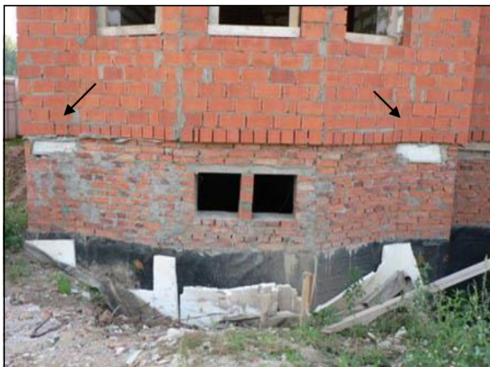
Рисунок А.18 – Фрагмент наружной кирпичной стены
