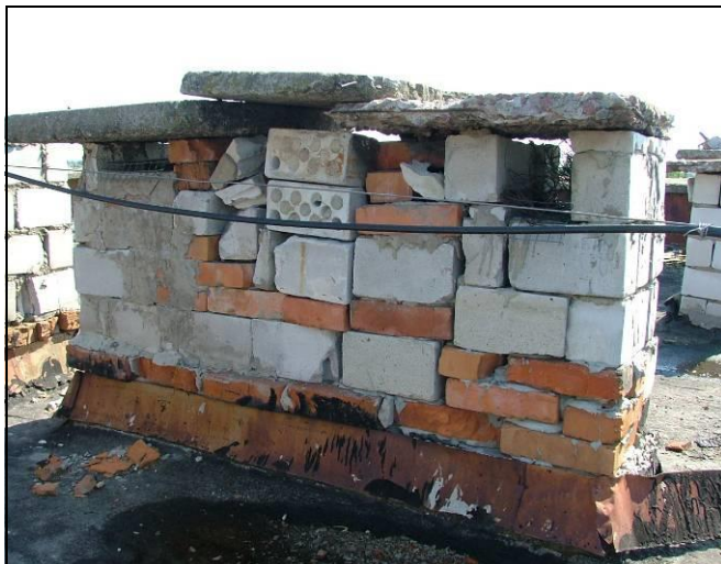
Вентшахта сложена из разнородных стеновых штучных материалов с многочисленными включениями боя кирпичей и камней без применения кладочного раствора
