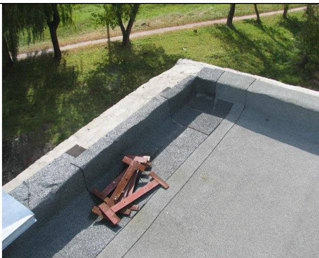
Рисунок А.91 – Фрагмент рулонной кровли
