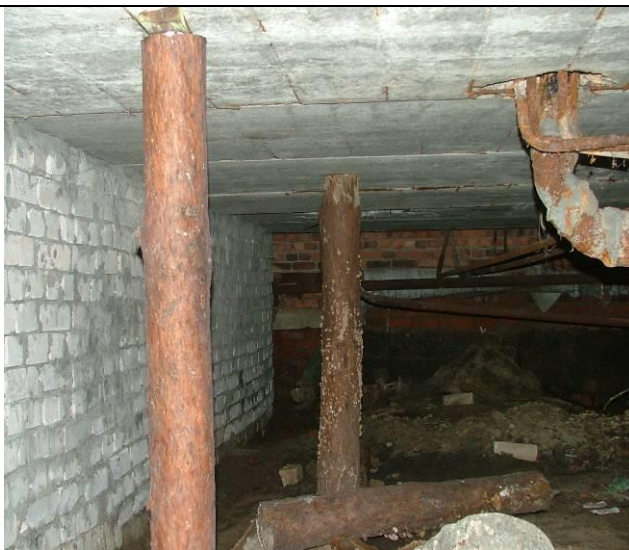
Рисунок А.60 – Фрагмент перекрытия над подвалом
