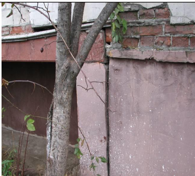
Рисунок А.31 – Фрагмент наружной кирпичной стены
