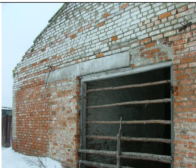
Рисунок А.43 – Фрагмент ж/б прогона
