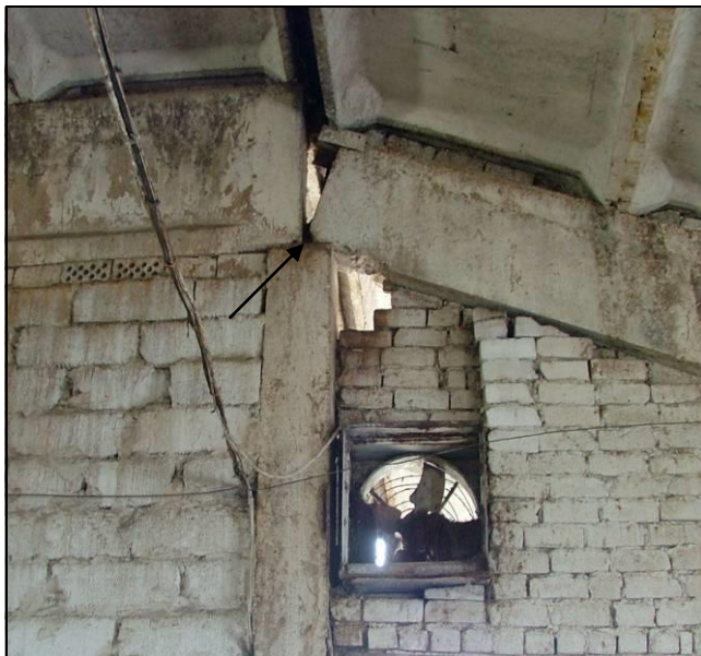
Опираение балки покрытия на колонну по краю без опорной площадки
