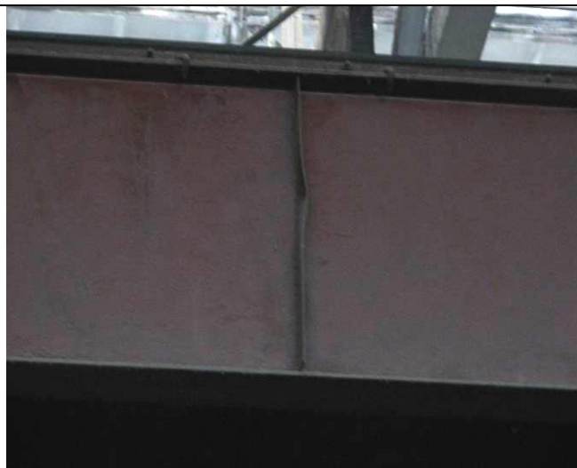
Погиб ребра жесткости на величину до 10 мм
