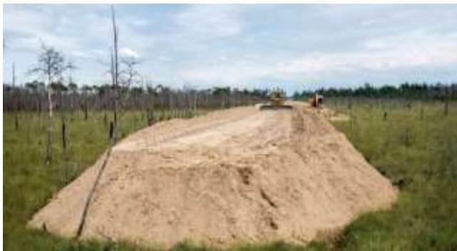
Рисунок 1 – Насыпь земляного полотна при строительстве дорог [2]
