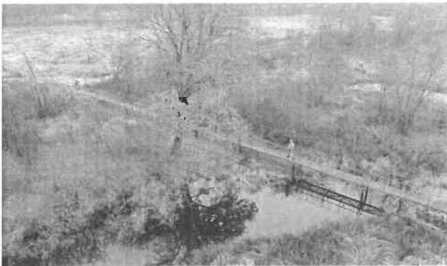
Рисунок 2 – Пример реализации пешеходного моста с использованием сборно-разборного металлического мостового пролета (СРММП-1) на болотистой местности
