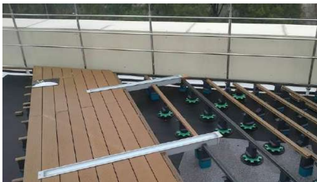
Рисунок 2 – Вид на покрытие кровли из террасной доски
