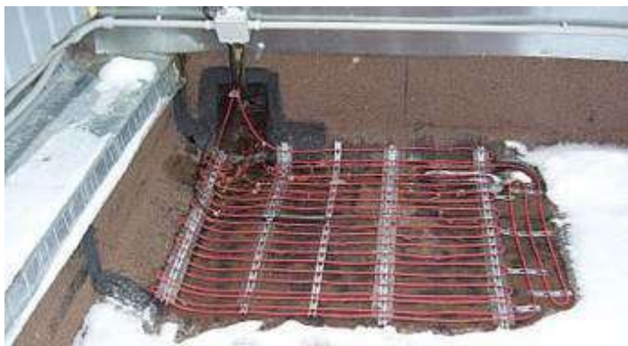
Рисунок 3 – Устройство водосточных воронок на эксплуатируемых плоских кровлях
