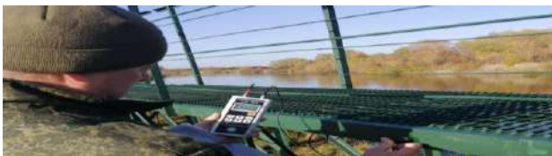
Рисунок 1 – Измерение толщины металла
