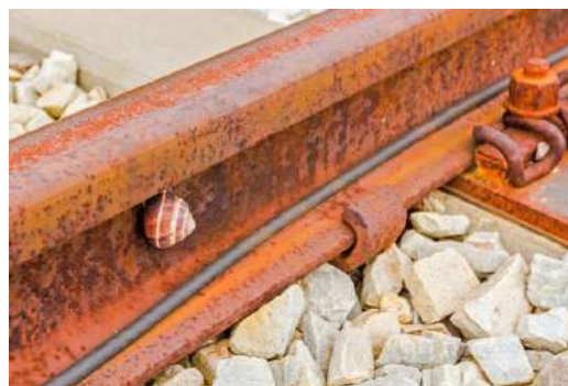
Рисунок 1 – Коррозия рельсов
