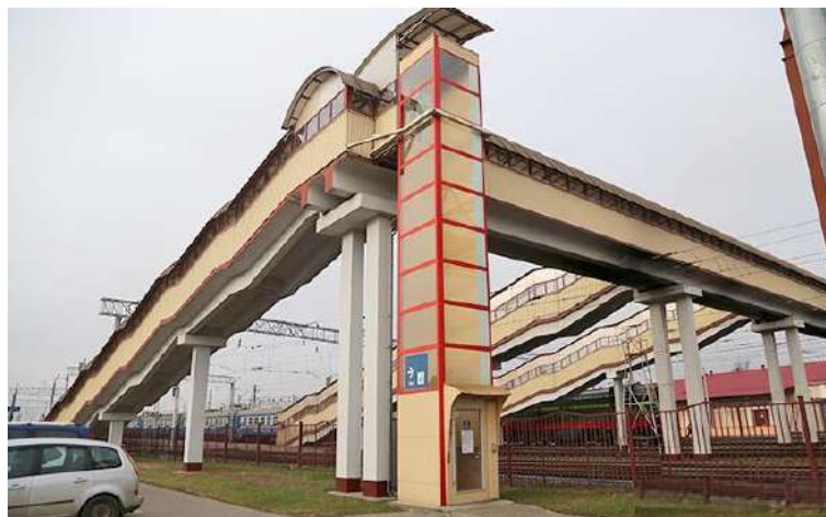
Рисунок 1 – Конкорс – мост железнодорожной станции Молодечно
