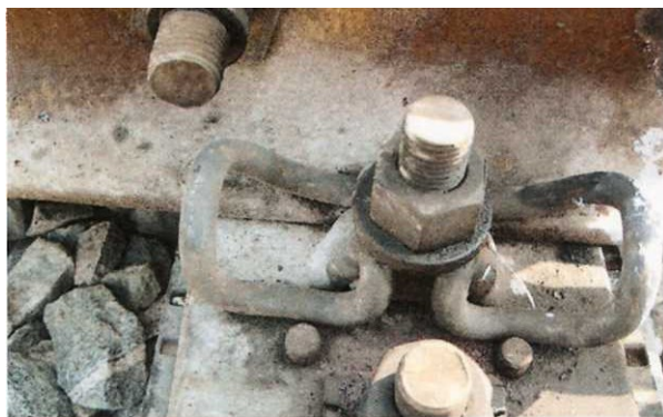
Рисунок 3.8 – Клемма Sk112-32 на стрелочном переводе пр. Дн 290
