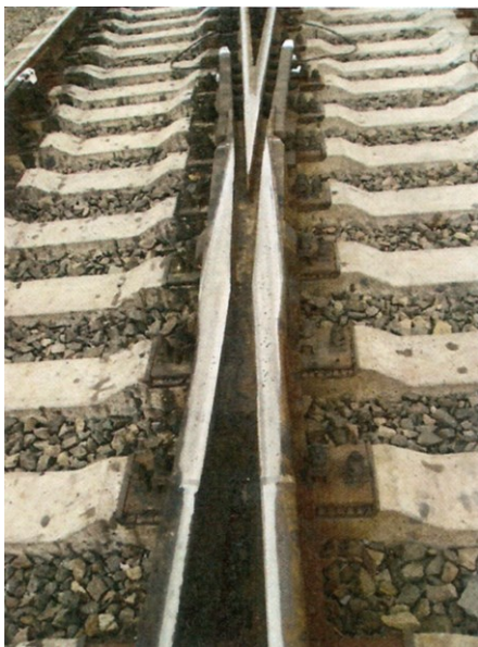
Рисунок 3.1 – Моноблочная крестовина
