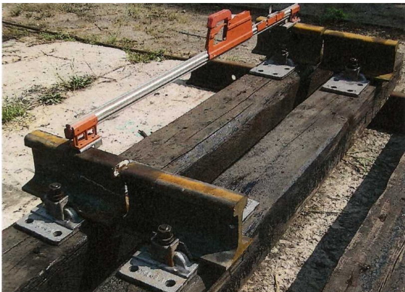
Рисунок 3.7 – СКД65 Д – скрепление для деревянных шпал
