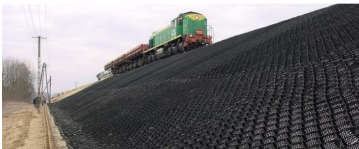
Рисунок 1 – Применение георешетки для укрепления откоса земляного полотна железнодорожного пути
