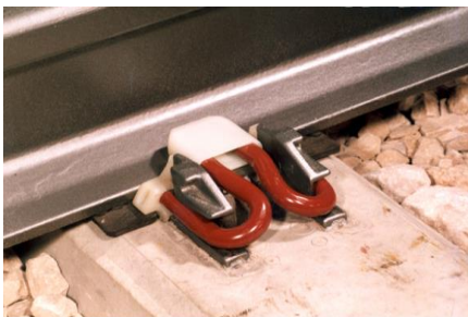
Рисунок 5 – Промежуточное рельсовое скрепление Пандрол-350
