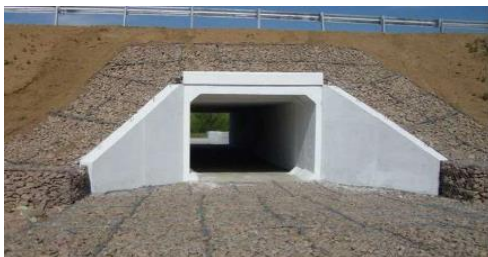
Рисунок 1 – Водопропускная труба, рассчитанная на пропуск колесного транспорта
