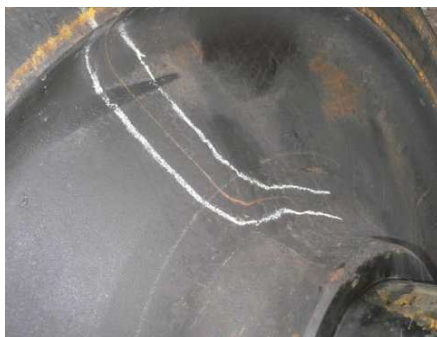
Рисунок 1.15 – Радиальная трещина колеса
