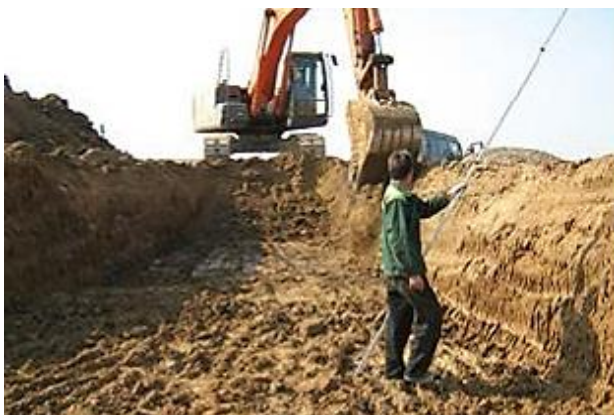
Рисунок 2.4 – Общий вид дна котлована при разработке грунта экскаватором
