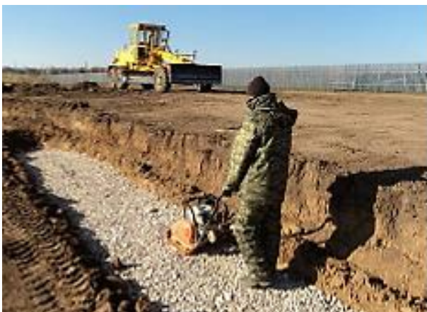
Рисунок 2.5 – Уплотнение щебеночной подготовки вибрационной плитой
