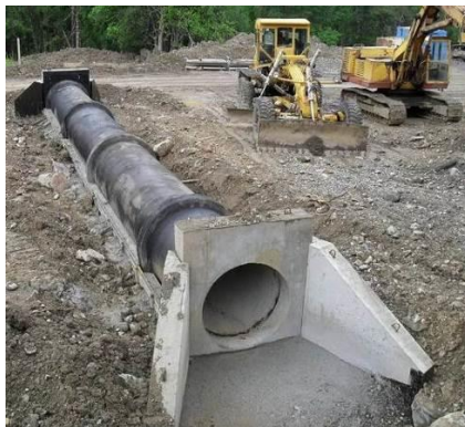
Рисунок 2.7 – Устройство гидроизоляции водопропускной трубы
