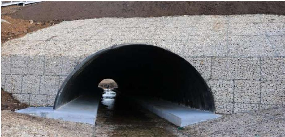
Рисунок 1 – Многофункциональная водопрпускная труба под земляным полотном железнодорожного пути
