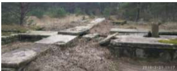
Рисунок 1 – Очистные сооружения в аг. Мосты Правые
