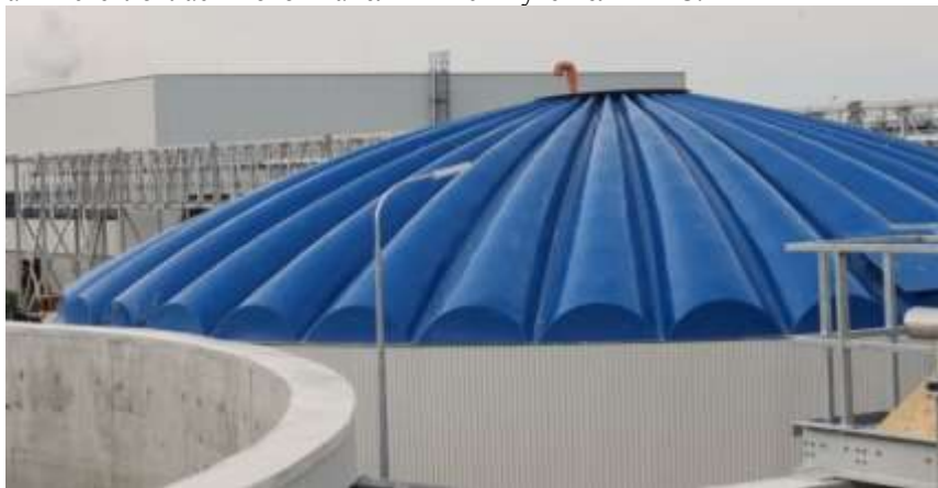
Рисунок 1 – Куполообразная конструкция перекрытия радиальных первичных отстойников
