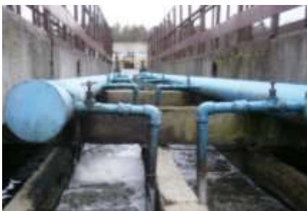
Рисунок 1 – Пена в зоне аэрации
