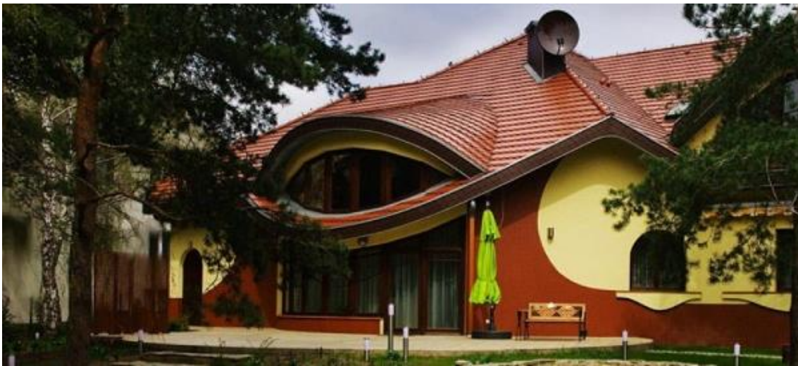
Рисунок 2.4 – «Дом-волна», архитектор Д. Облуск, Варшава, Польша, 2012
