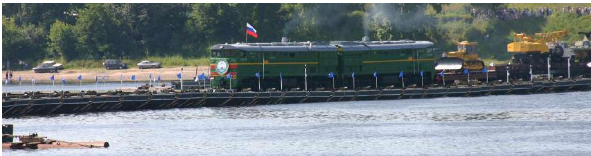
Рисунок 1 – Общий вид моста-ленты МЛЖ-ВФ-ВТ
