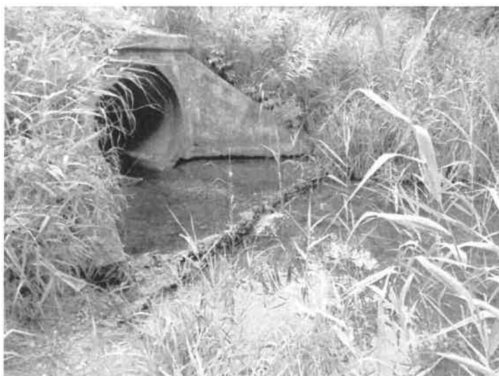
Рисунок 2 – Железобетонная труба под дорогой Р-116 вблизи д. Вашково (Ушачский район)
