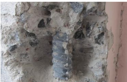
Рисунок 1 – Фрагмент колонны крайнего ряда Условия эксплуатации – общественное здание. Срок эксплуатации – 10 лет. Стальная арматура находится в пассивном состоянии, следы коррозии отсутствуют
